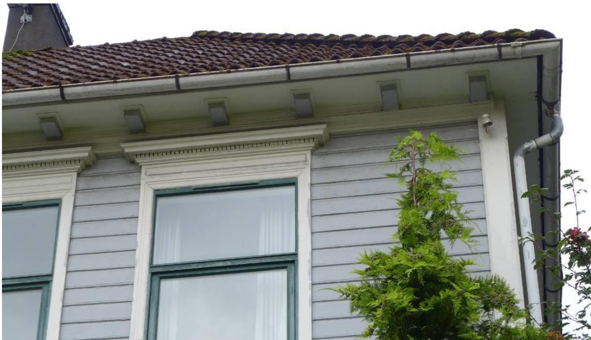
Figur 11: Ut mot gaten er takutstikket kasset inn med horisontal underside, og dekorert med tannsnittbord. Hjørnebordene markerer husets hjørner.
