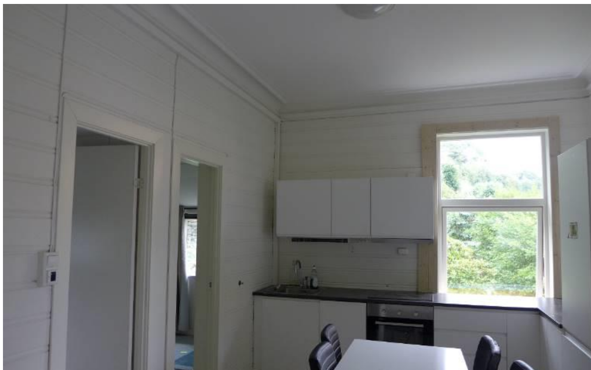
Figur 27: Vi finner også en del profilert, historisk listverk mot tak og mot gulv, slik som disse taklistene. Mulig finnes det også mer intakt listverk bak nedsenkede himlinger i andre rom.
