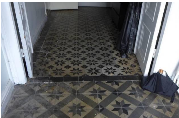
Figur 24: Like innenfor begge inngangsdørene er det felt med historiske gulvfliser med åttebladsroser. Slike fine gulv var også vanlige i leiegårder på 1800-tallet.
