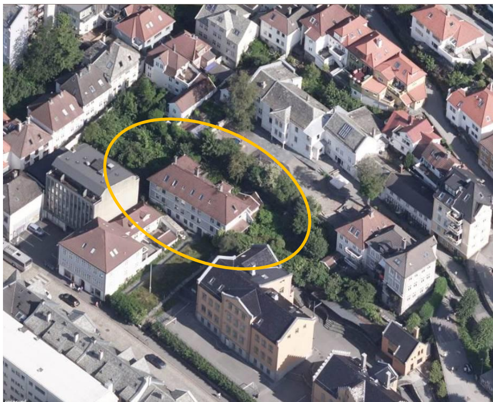
Figur 6: Flyfoto over Øvregaten. Øvregaten 5 er markert med oransje sirkel (Foto: flyfoto Blom og Bergen kommune).
