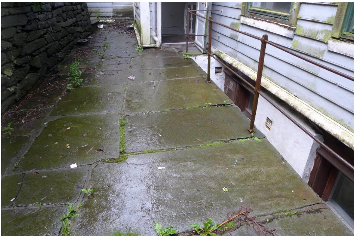
Figur 35: Over den smale «kjellerhalsen» er et flatt parti med store skiferheller og smijernsrekkverk. Til venstre kommer nok en høy mur, så et grønt hageparti, før den høye, lange støttemuren i grensen mot Krybbesmauet.
