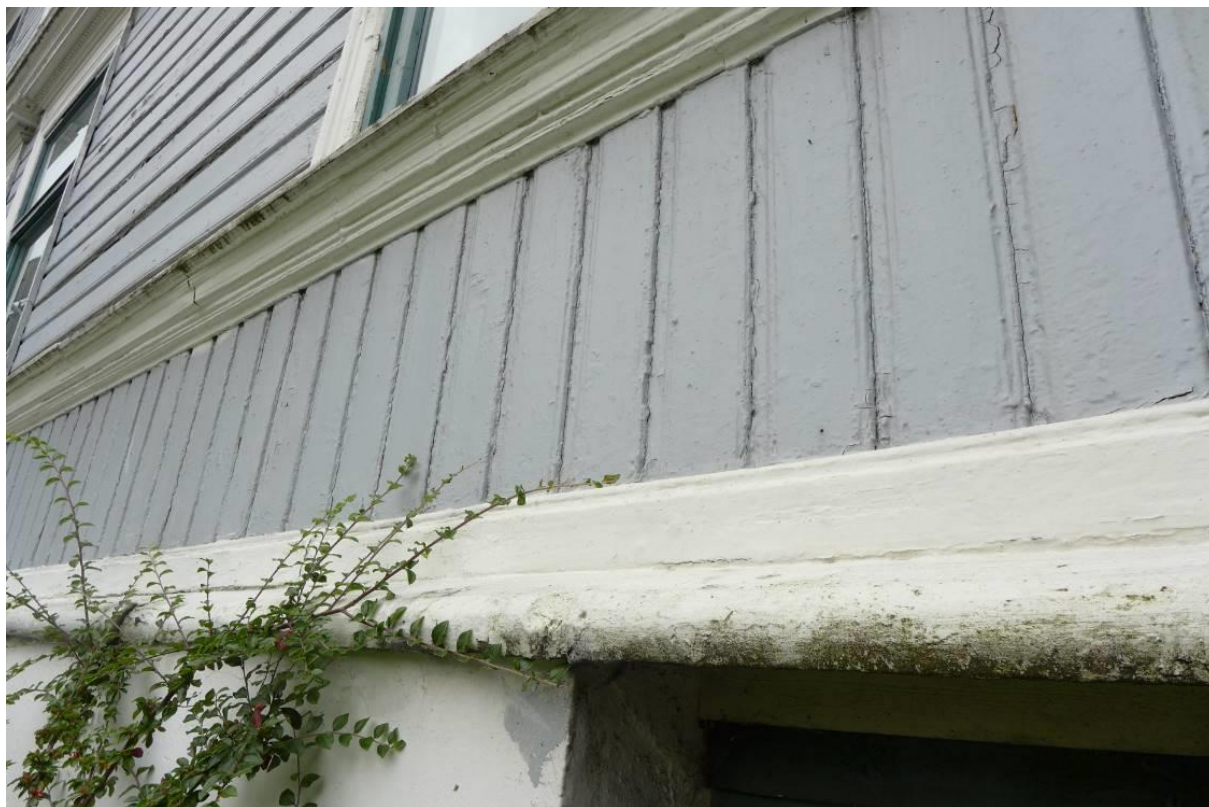
Figur 15: Huset har gammelt pløyd/dobbelfalset og profilert panel. De to hovedetasjene er markert i fasaden med stående panel under vinduene, samt profilerte etasjebesimser med kraftig relieff og høy rygg. Vannbordet nederst på fasaden mot kjelleretasjen er avrundet.
