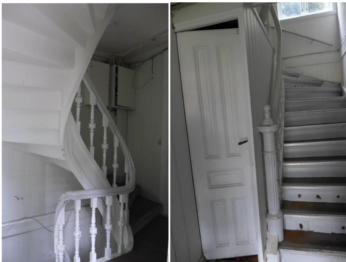
Figur 21 og 22: Begge de historiske trapperomsmiljøene er godt bevart. Her fra sørenden, med buet trapp helt til loftet, dreide stolper og gelender, håndlist, panelte vegger, gamle dører mm.
