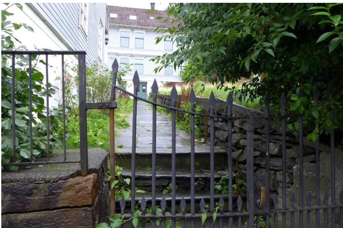
Figur 38: Ut mot gaten er det en gammel smijernsport med spydmotiv. En murt trapp med rundede skifertrinn leder fra gatenivå og opp til adkomstveien.
