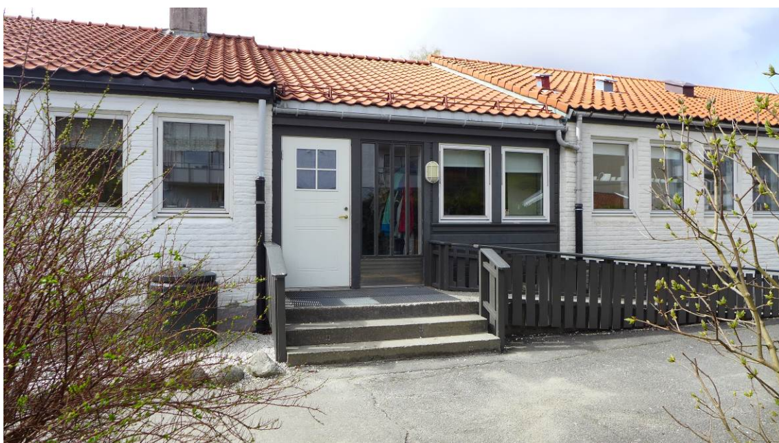
Figur 9: Det sørligste mellombygget ble bygget om i 1997. Da fikk det saltak, og ytterveggene ble trukket ut i linje med de to hovedvolumene, noe som har svekket det opprinnelige hovedpreget noe. Det svake spranget i takflaten viser likevel hvor det har vært en oppdeling av den lange fasaden (Byantikvaren 2015).
