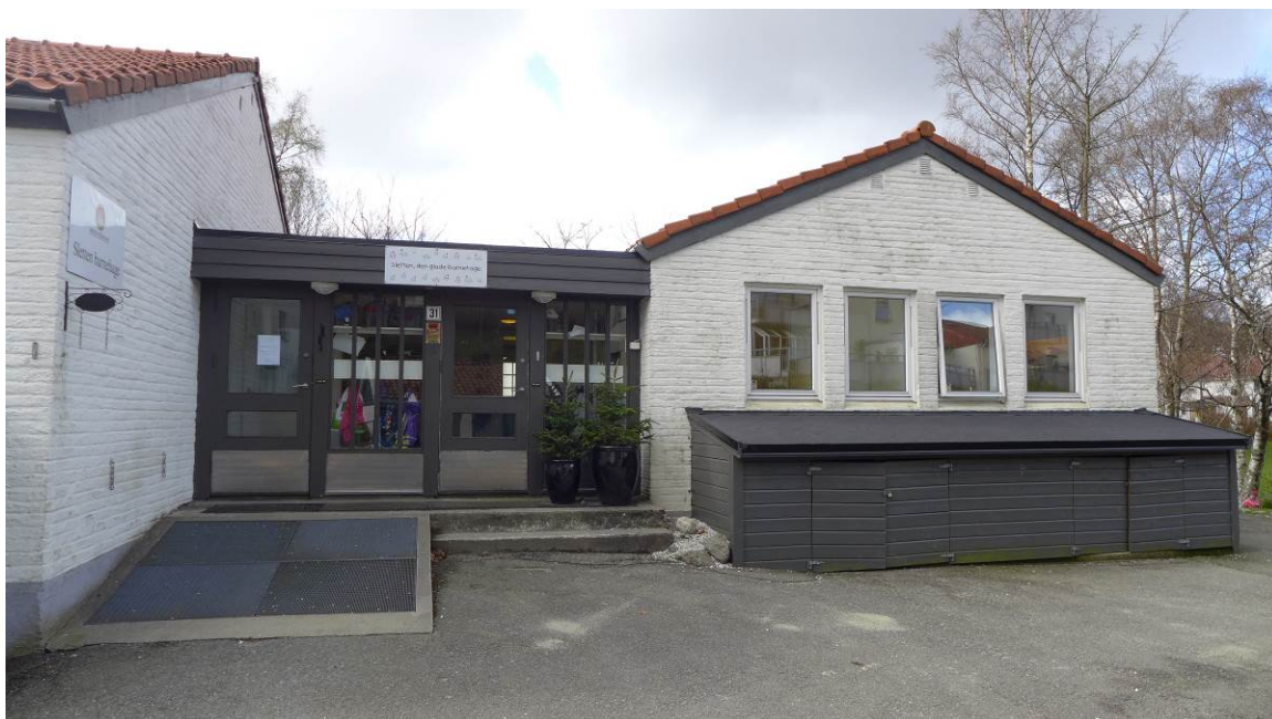
Figur 10: Det nordligste mellombygget er forholdsvis godt bevart, i alle fall i hovedtrekkene. Dørene skiller seg fra opprinnelige tegninger, men ser ut til å være av eldre type. De er i dag malt grå (Byantikvaren 2015).
