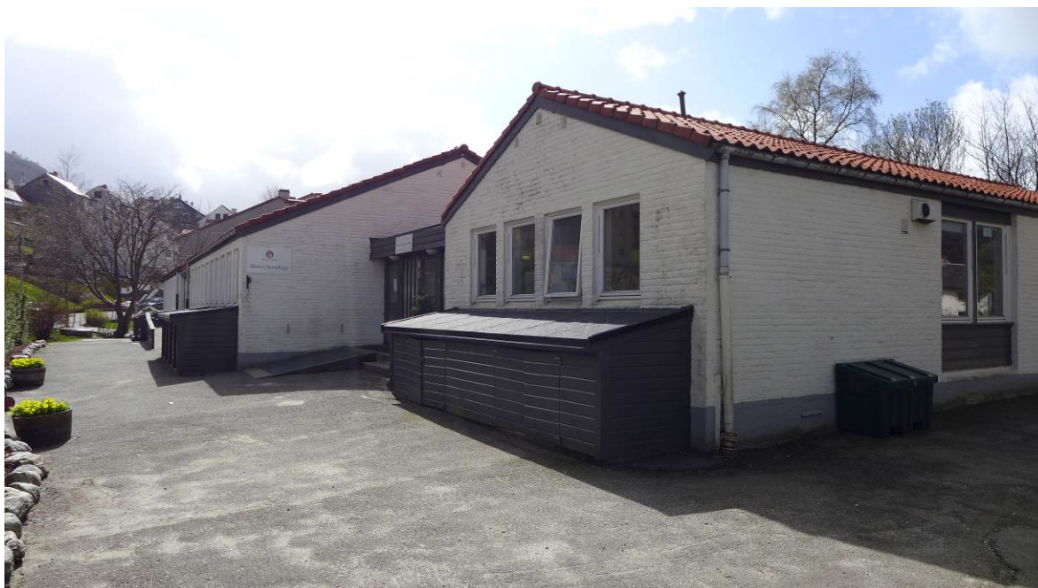
Figur 8: Barnehagen sett fra nordøst. Til høyre i bildet ses et vindu med brystningsfelt i trepanel (Byantikvaren 2015).
