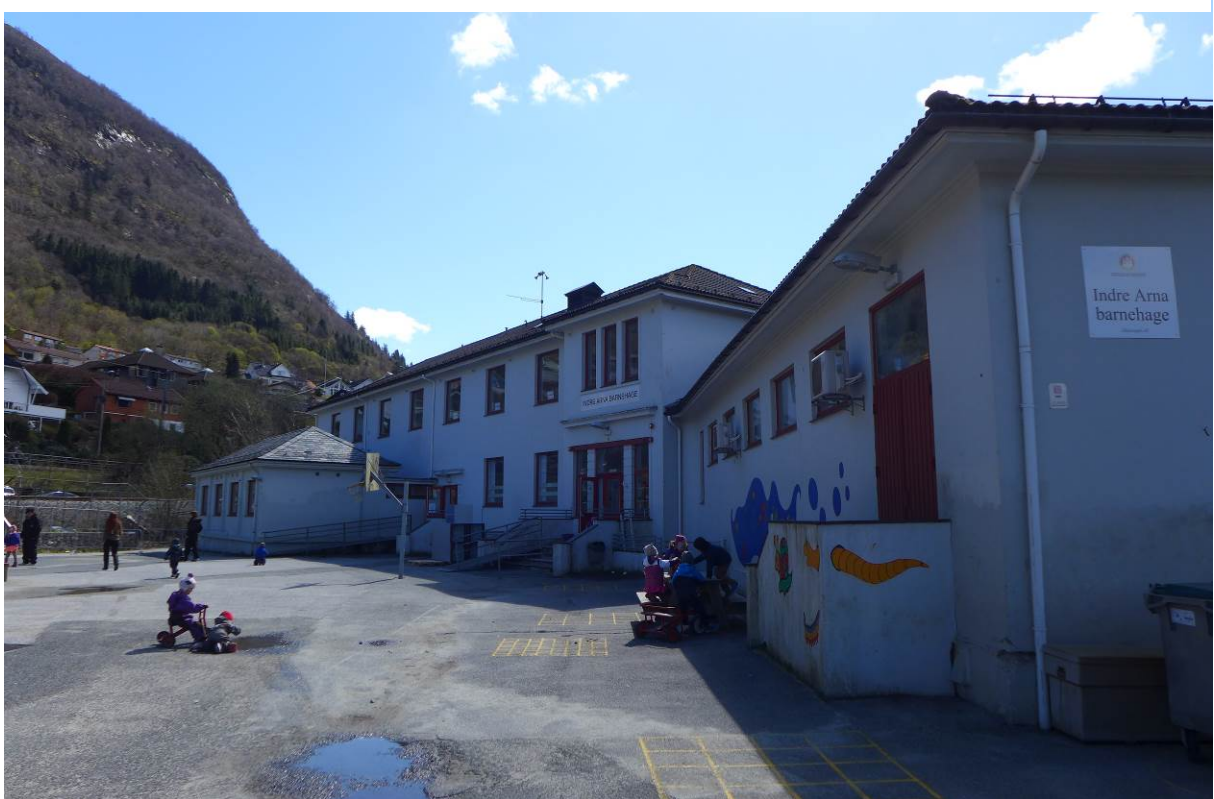
Figur 27: Foto av Indre Arna skule med uteoppholdsareal. Lekeområdet er delvis asfaltert og belagt med dempematter (Foto: Bergen kommune, Byantikvaren 2015).
