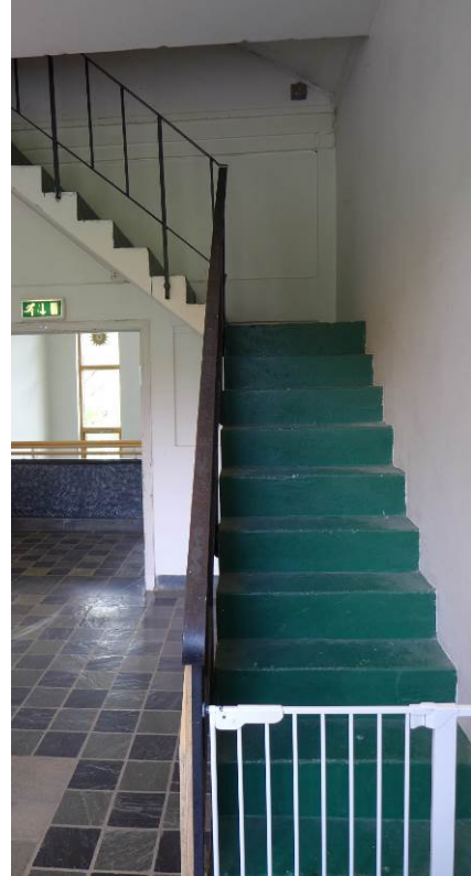
Figur 22: Godt bevart trappeløp opp til råloft (Foto: Bergen kommune, Byantikvaren 2015).
