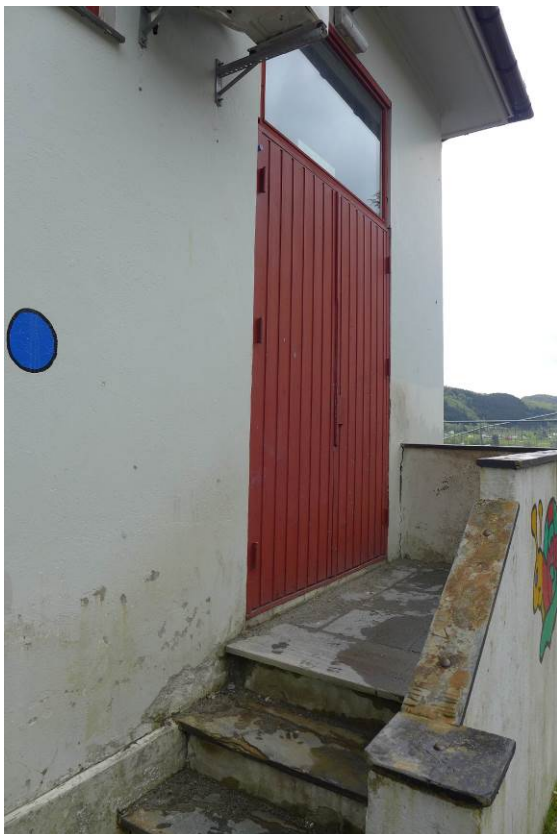
Figur 8: Gammel inngangsdør til gymsalen (Foto: Bergen kommune, Byantikvaren 2015).
