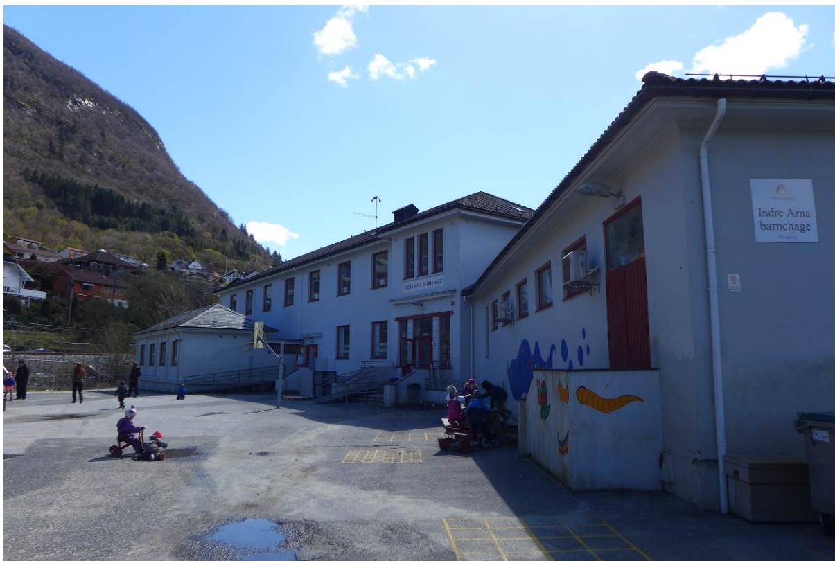
Figur 5: Foto av hovedbygningens fasade mot nordøst. Det siste tilbygget foran hovedbygget ligger lengst bak i bildet (Foto: Bergen kommune, Byantikvaren 2015).
