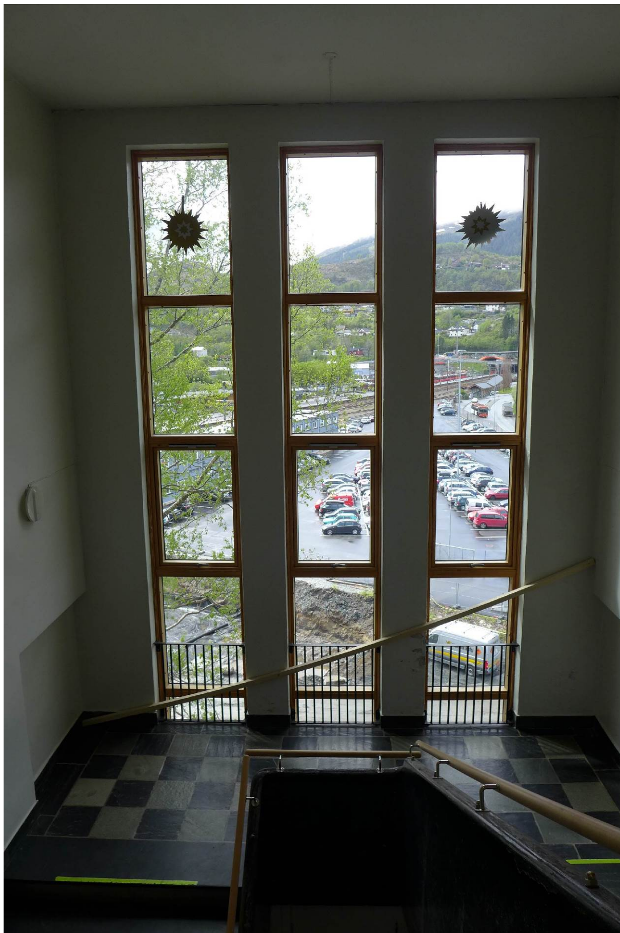
Figur 19: Godt bevart trapperom fra det opprinnelige hovedbygget. Monumentalt rom med stor vindusflate. Det er i nyere tid påmontert forhøyet rekkverk på original håndlist (Foto: Bergen kommune, Byantikvaren 2015).
