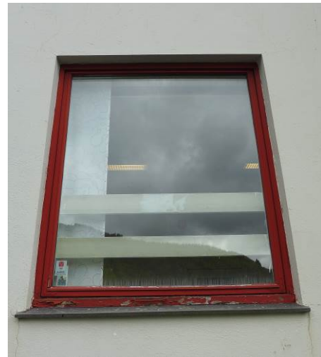
Figur 7: Eksempel på gammelt vindu ut mot gårdsplassen (Foto: Bergen kommune, Byantikvaren 2015).
