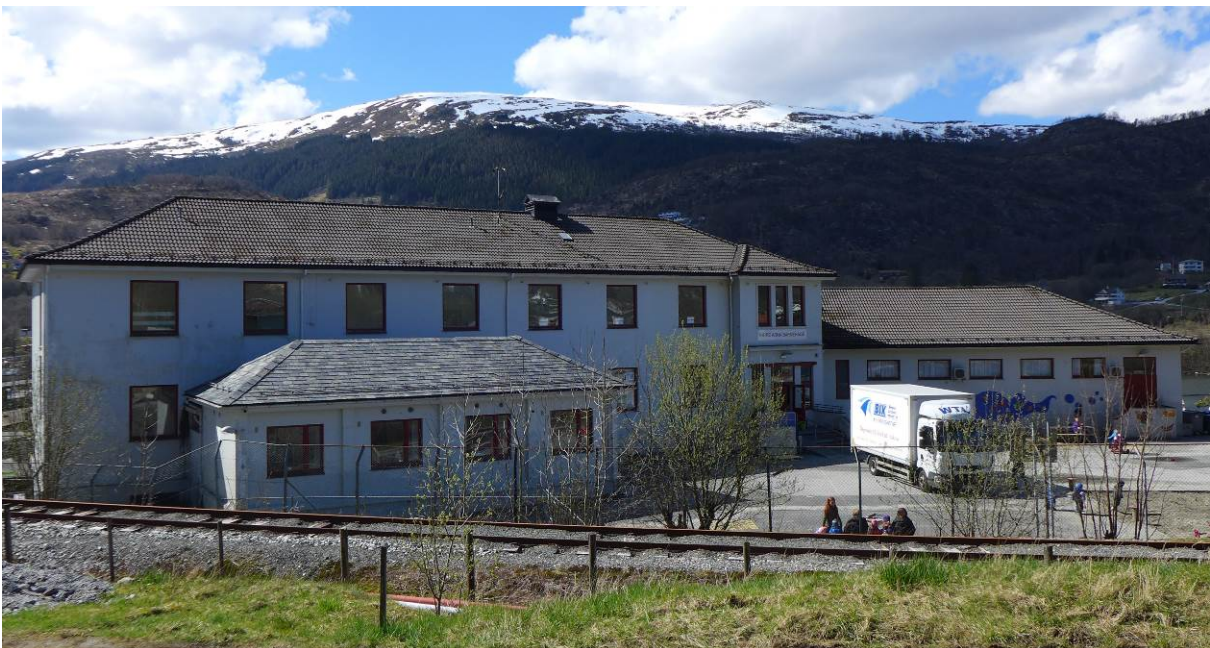
Figur 15: Hovedbygningen og fløyen med gymsal har i dag svart betongtakstein. Det mindre tilbygget fra 1971 har fortsatt opprinnelig skifertakstein (Foto: Bergen kommune, Byantikvaren 2015).
