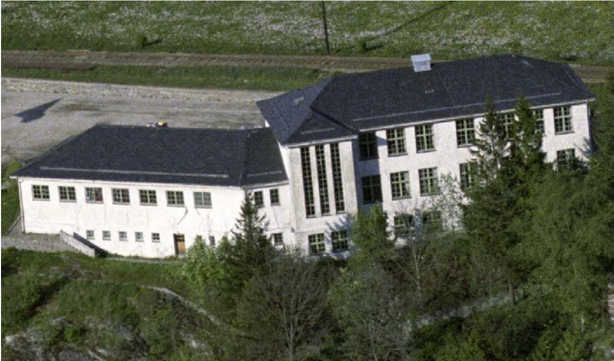
Figur 10: Flyfoto av Indre Arna skule fra 1961. Bildet viser bygget før det ble forlenget mot sørøst. Bildet viser også at vinduene er skiftet, og at vinduskarmene på denne tiden var malt grønne (Foto: Billedsamlingen, UiB, ubb-w-f-017733 (utsnitt)).
