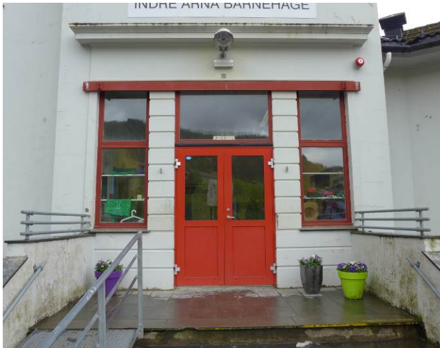
Figur 6: Byggets hovedinngang som vender seg ut mot gårdsplassen. Døren er ny og av aluminium, den ble trolig satt inn i forbindelse med etableringen av barnehagen (Foto: Bergen kommune, Byantikvaren 2015).
