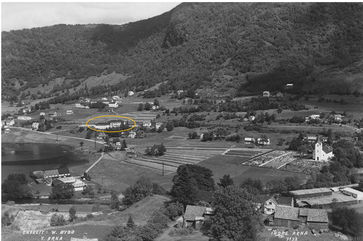
Figur 1: Flyfoto av skolen fra 1961. Bildet viser hvordan bygningen ble plassert i landskapet, og hvordan den så ut før den ble bygd på mot sørøst (Foto: Billedsamlingen, UIB, ubb-w-f-017733).
