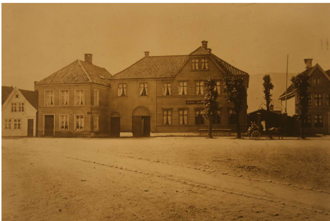
Figur 6. Klosteret 2 før fasadeombyggingen i 1880-årene. Den venstre del av fasaden er murforblendet, mens den høyre står med trekledning. Legg merke til trærne i forgrunnen (Kilde: Riksantikvarens arkiv).
