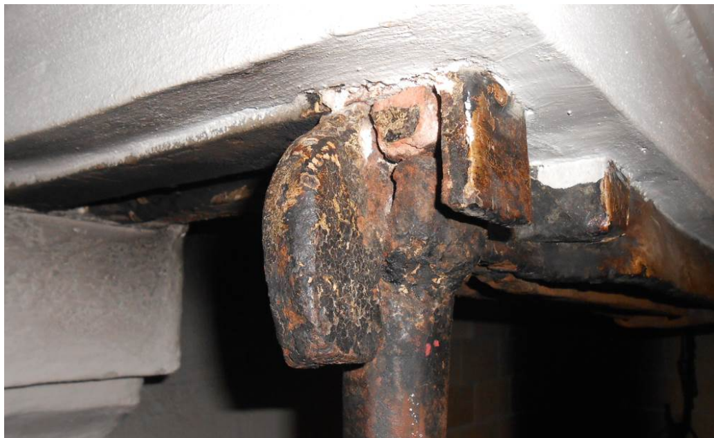
Figur 14. Grue i Nordnes bydelshus. Detalj på den smidde jernstøtten (Foto: Byantikvaren 2015)
