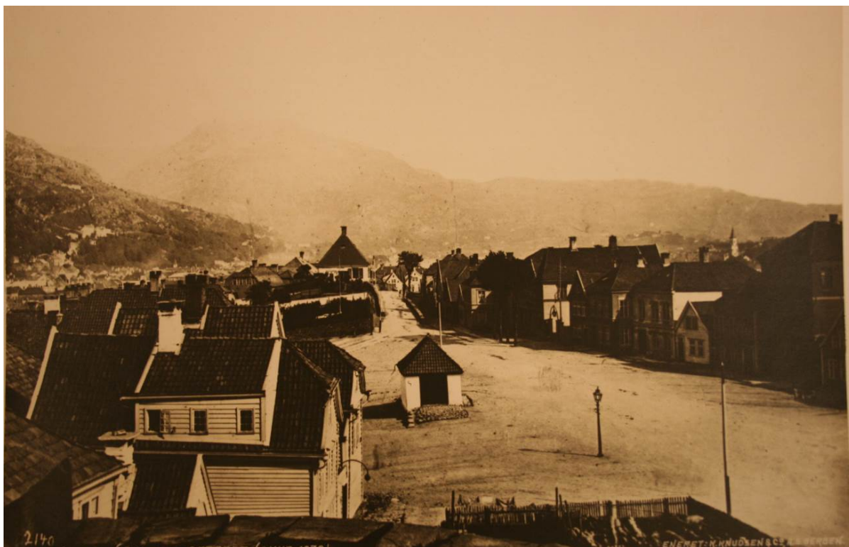
Figur 4. Klosteret i 1879. Vi ser fremdeles den gamle trebygningen midt i bildet. Andre hus på Klosteret har nå fått murforblendig på fasadene mot gaten (Kilde: Riksantikvarens arkiv).
