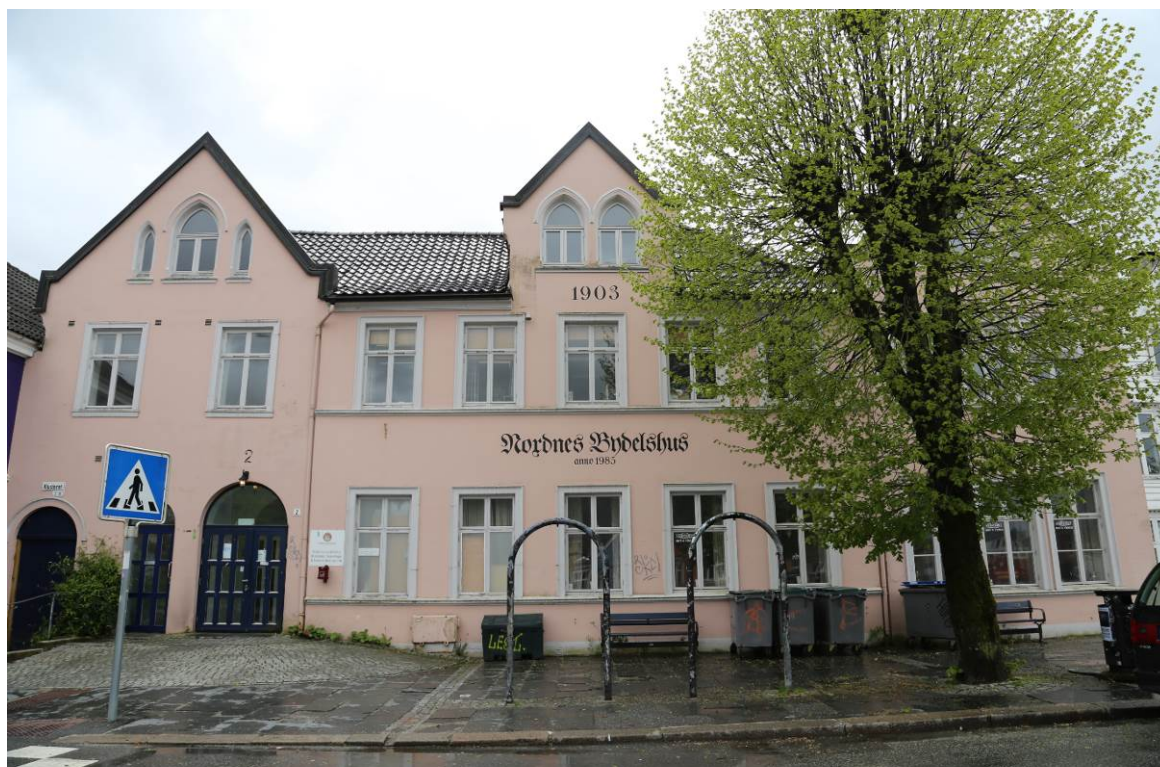
Figur 8. Bygningen i dag. Helt til venstre ses den lille døråpningen, som også er på begge foregående bilder. Hovedinngangen er tilbakeført til slik den var før 1880. Foran står det siste av trærne som vinhandler Krohn plantet (Foto: Byantikvaren 2015).
