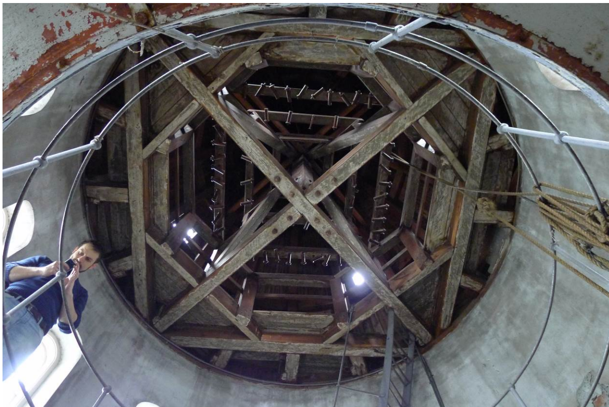
Figur 9. Øvre del av slangetårnet. I toppen står fortsatt festene for brannslangene (Foto: Byantikvaren, Bergen kommune 2015).
