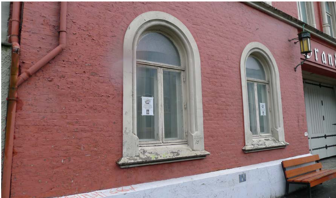
Figur 6. Fasade ut mot Christies gate. Vinduene ble satt inn i 1934 i forbindelse med gjenmuringen av de to tidligere inngangsportene som lå i hver sin ende av fasaden (Foto: Byantikvaren, Bergen kommune 2015).
