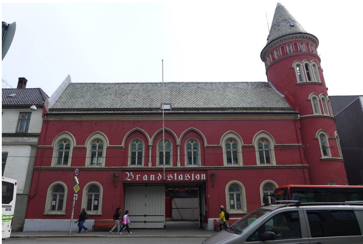
Figur 5. Vestfløyens fasade ut mot Christies gate. Fasaden ble endret i 1931 i forbindelse med ombygging til ny midtstilt hovedport (Foto: Byantikvaren, Bergen kommune 2015).
