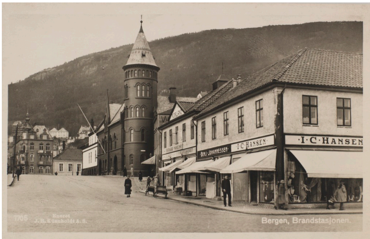
Figur 4. Historisk foto av brannstasjonen fra 1921. Bildet viser fasaden ut mot Christies gate før ombyggingen i 1931. Bygget fremstår her med opprinnelig midtrisalitt med avsluttende kvistgavl og med teglsteinsfasader uten slemming (Foto: Billedsamlingen, UIB, ubb-bs-pkb-00213_md).
