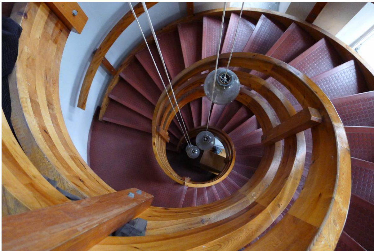
Figur 10. Nedre del av slangetårnet (Foto: Byantikvaren, Bergen kommune 2015).
