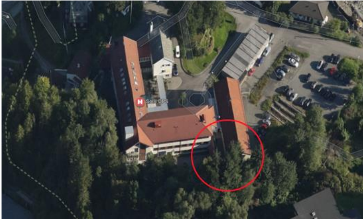
Figur 4.2.2.2 – Flyfoto av Solli DPS og vegetasjon som skygger. Kilde: Skråfoto fra kart.1881.no
