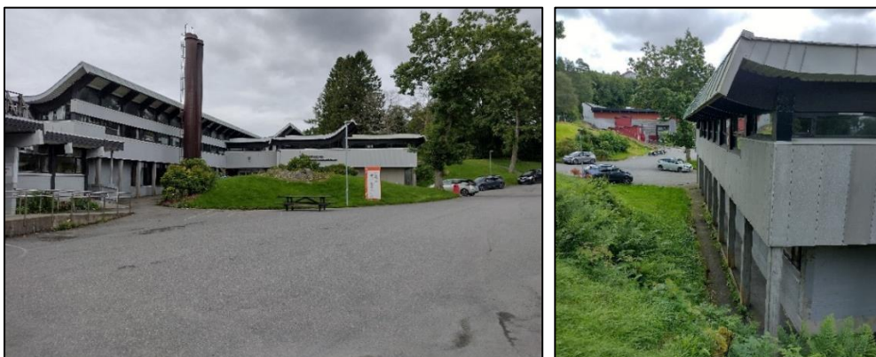
Figur 3.1.3.7 – Slåtthaug VGS, hovedbygg. Hovedinngang ligger bak den lille haugen (t.v.) Detalj av konstruksjon (t.h.).
