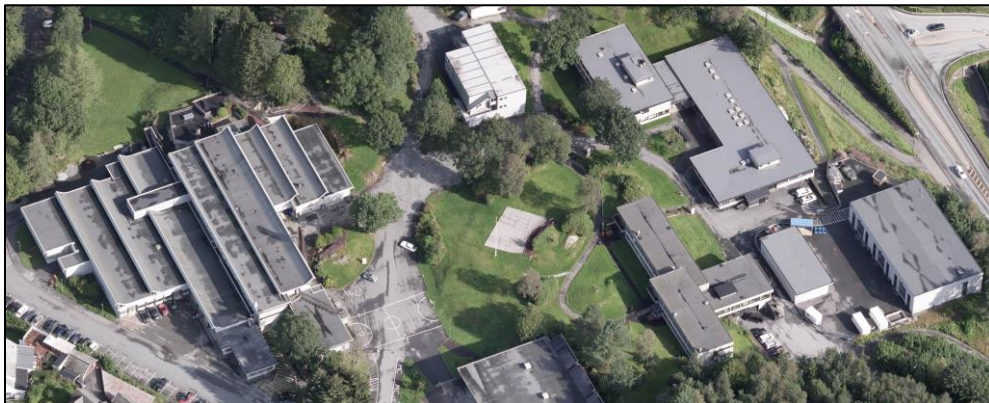
Figur 3.1.3.6 – Slåtthaugvideregående skole. Bygget til venstre er innenfor plangrensen, men byggene til høyre er like utenfor. Kilde: skråfoto fra kart.1881.no
