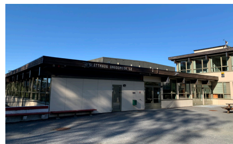
Nåværende situasjon: Overdekket areal/tidl. leskur ved hovedinngang er bygget igjen.
