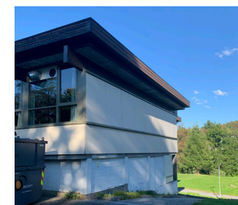
Nåværende situasjon: Søyler ved kortfasade mot sør er bygget inn.
