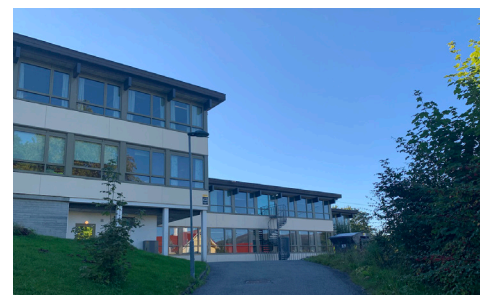
Nåværende situasjon: Overbygget areal og eksponerte søyler ved inngang mot øst.
