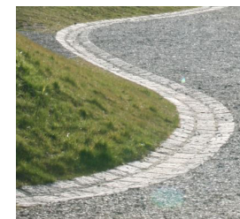
Overvannsrenner i brostein
