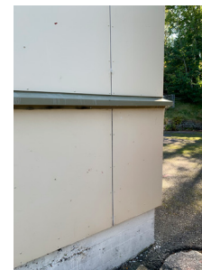
Beslag mellom vindu og horisontale bånd rundt kortfasader, fjernes
