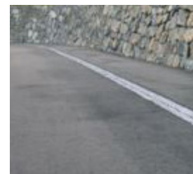
Adskilt visuell markering mellom kjørebane og gangareal
