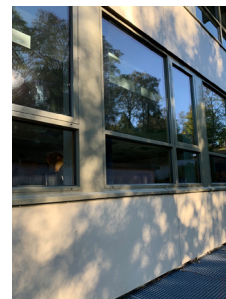
Beslag mellom vindu og horisontale bånd rundt kortfasader, fjernes
