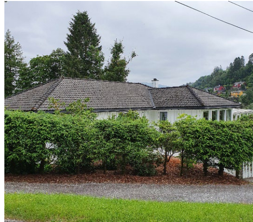
Enebolig fra 1999, Osvegen 21
