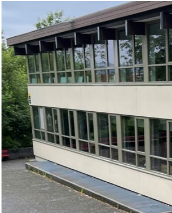
Fasade vest, nedre del (i nord).
