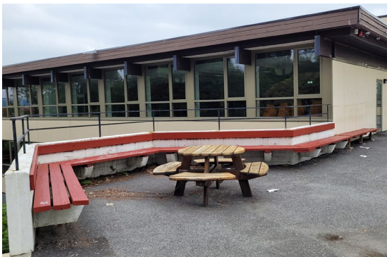
Opprinnelige integrerte benker øvre nivå
