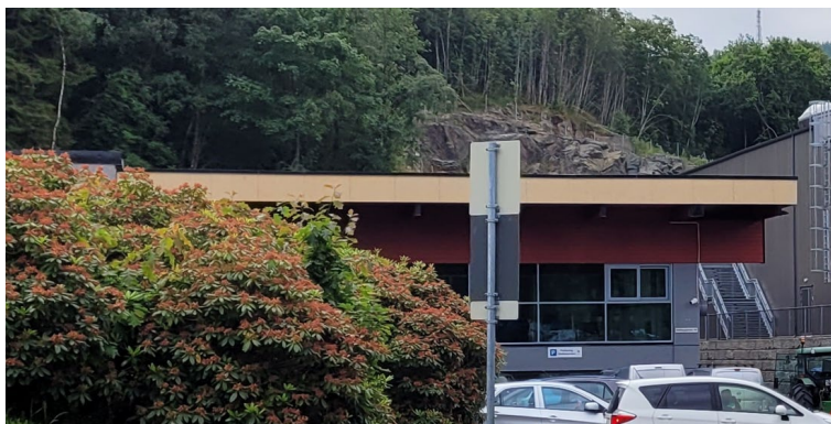
Slåtthaughallen, sørfløyen, fasade mot nord
