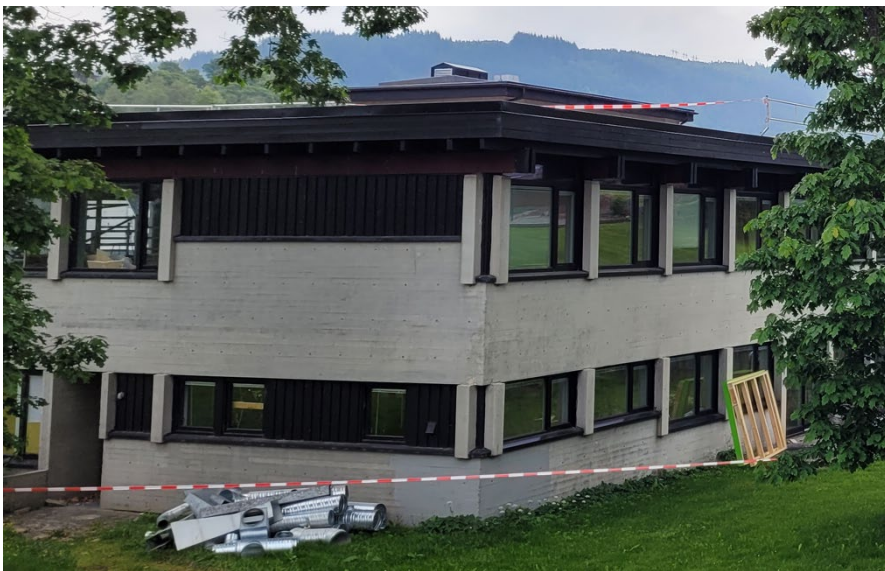
Slåtthaug vgs. bygg B, hjørne i nordvest mot Slåtthaug skole
