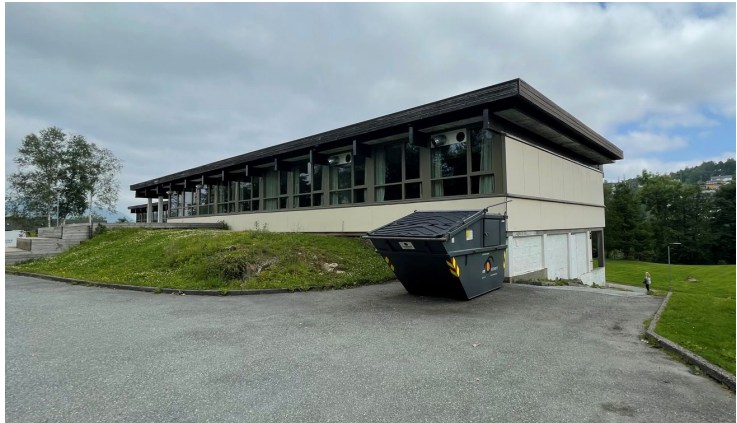
Fasade vest, øvre del. Vegg tettet til hvor det opprinnelig skulle vært søyler(i sør).
