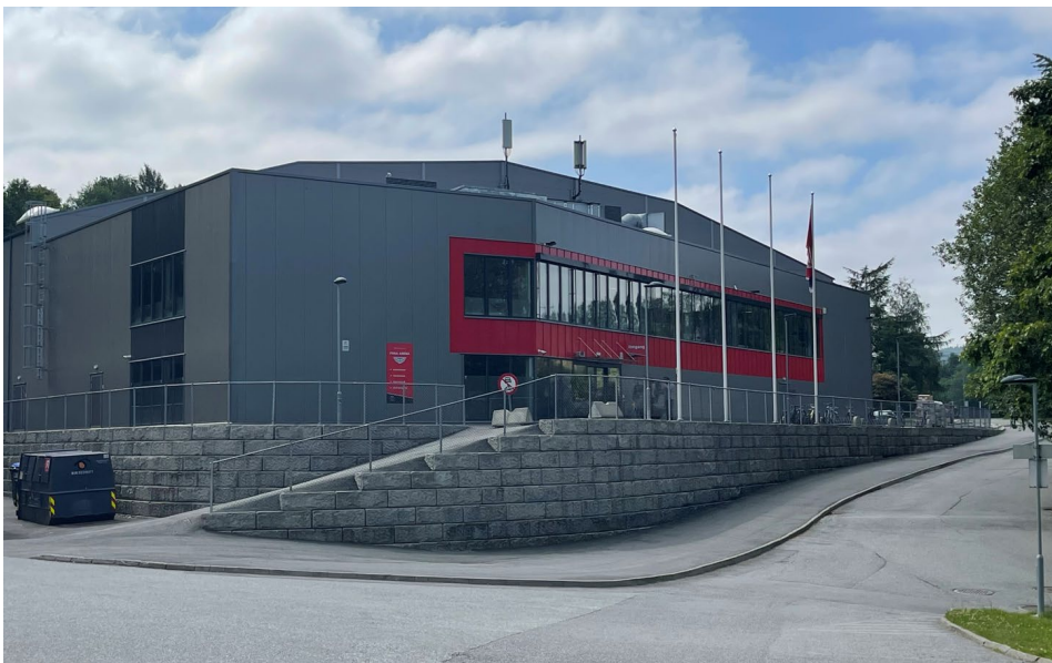
Fana Arena, hovedfasade mot nordvest
