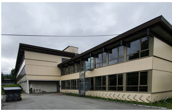
Fasade og hjørner mot nordøst. Rømningsvei og sykkelstativ av nyere dato.
