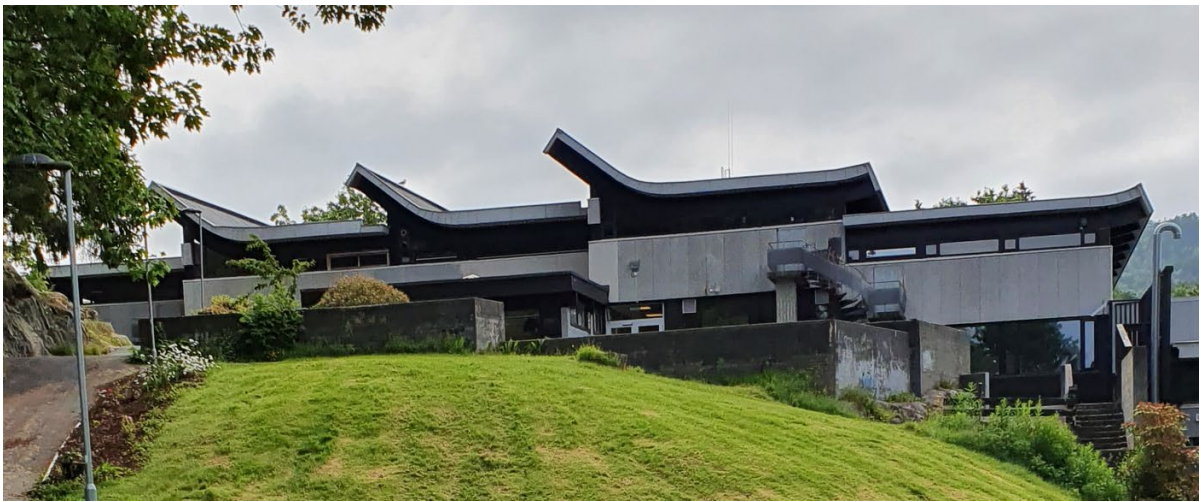
Slåtthaug vgs. bygg A, fasade mot nord
