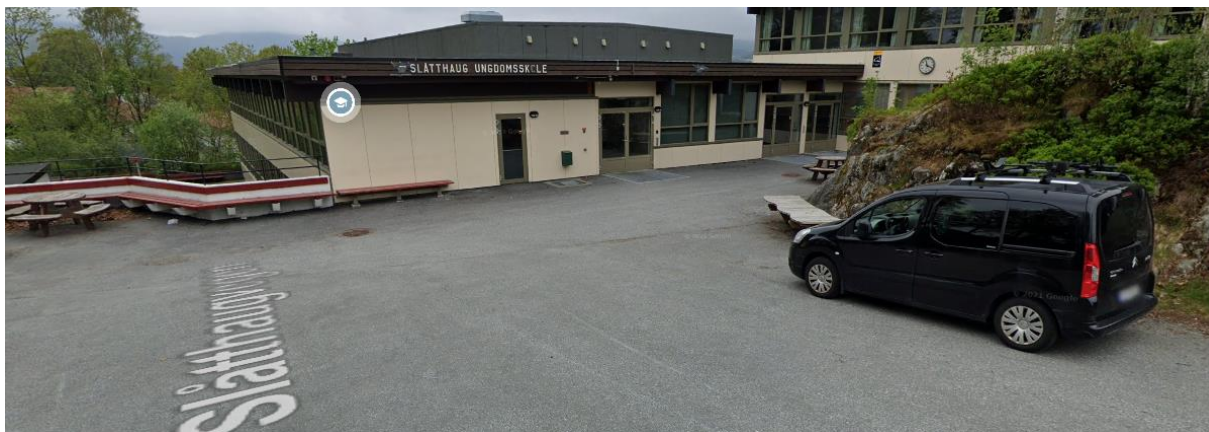
Figur 6: Eksisterende hovedinngang til Slåtthaug ungdomsskole. (Skjerm bilde fra Google Street View, mai 2019)
