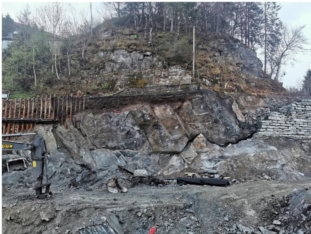
Figur 3: Bilde av utført sikring ovenfor Apeltunvegen 2A. Hentet fra Wimo sikringsrapport (7.mai 2021).
