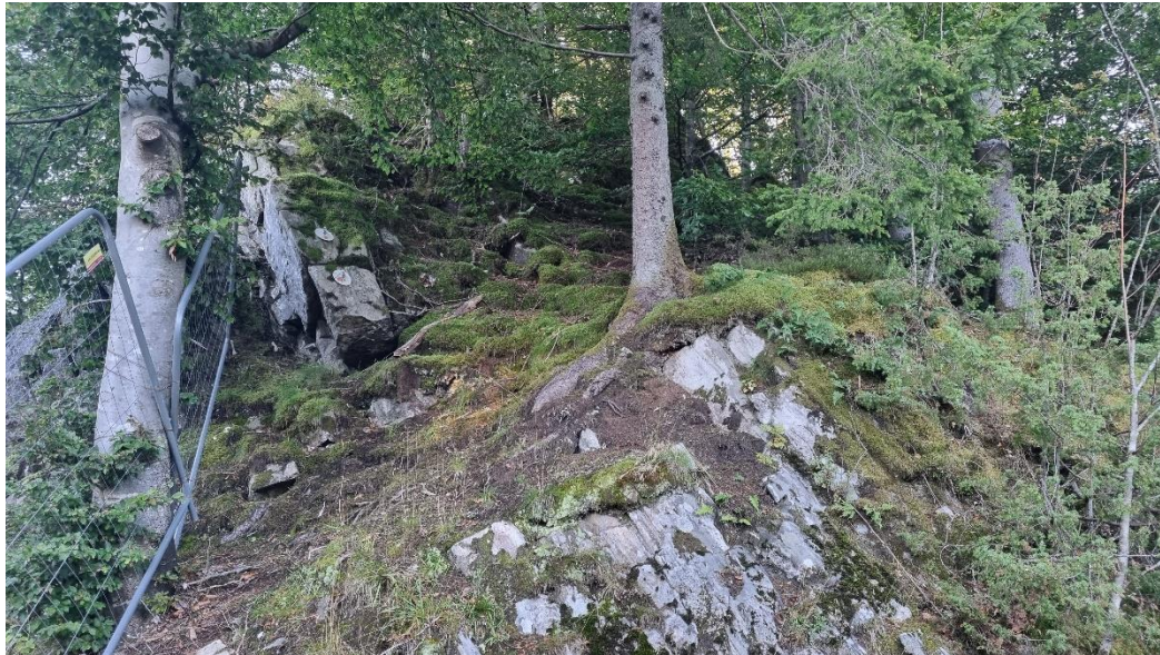
Figur 8: Sikringstiltak utført i tidligere fastsatt faresoneområde på nordvestlig side av kartleggingsområdet.
