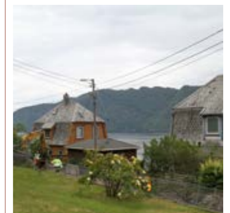
Boligstrøkenes bebyggelsesstruktur er viktig for Arnas særpre. Flere av bygningene fremstår som relativt autentiske, ofte med dråpskifertak, selv om vindu- og vindusinndeling, kledning etc. gjerne er fjernet og erstattet med nye materialer.
