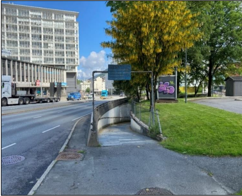
Figur 24: Undergang ved Fjøsangerveien. Foto: Norconsult, juni 2021.
