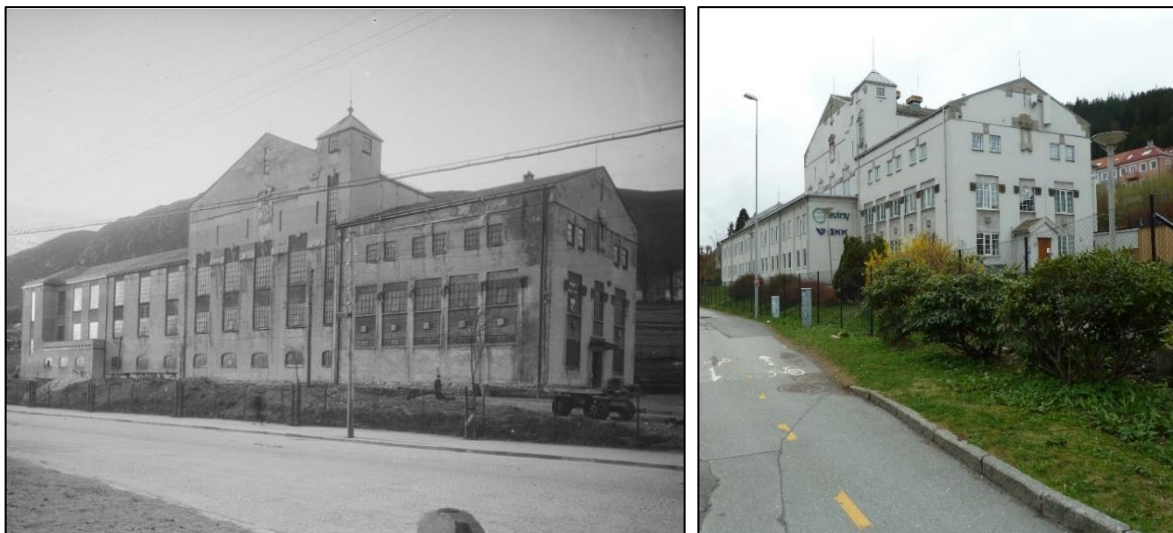
Figur 49: T.v. Solheim transformatorstasjon, Fjøsangerveien. Bildet viser bygningen med tilbygg etter 1924 (Markus.uib.no). T.h. Solheim sekundærstasjon dagens situasjon, med bakenforliggende boligområde.
