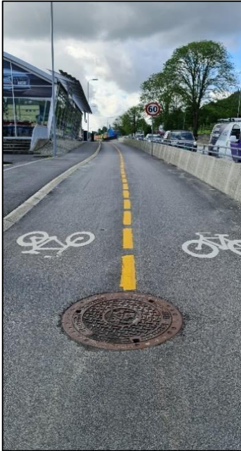
Figur 26: Fjøsangerveien sett fra nord. Foto: Norconsult, juni 2021.
