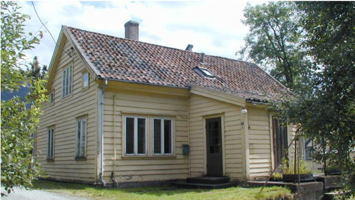
Figur 3-3 Våningshuset tilhørende Solheimsmyren gård. Fotografert i 2002, samme år som det ble revet. Kilde Årstadposten.
