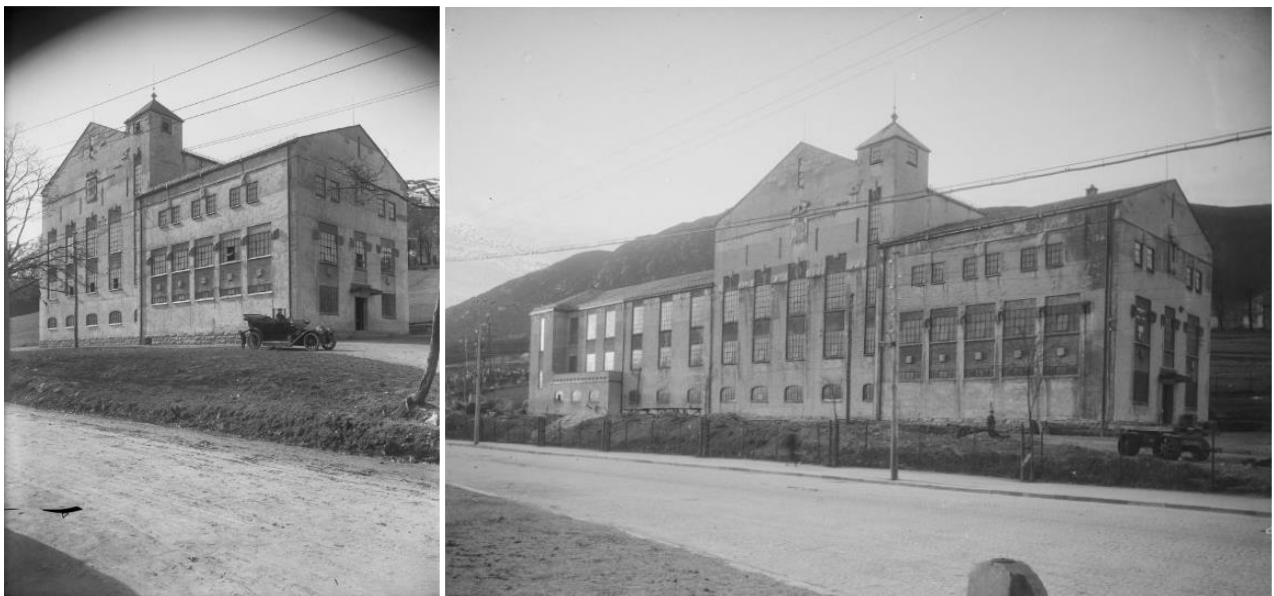
Figur 3-11 Solheim Sekundærstasjon, Fjøsangerveien 65. Bildet til høyre viser bygningen med tilbygg, etter 1924. Markus.uib.no
