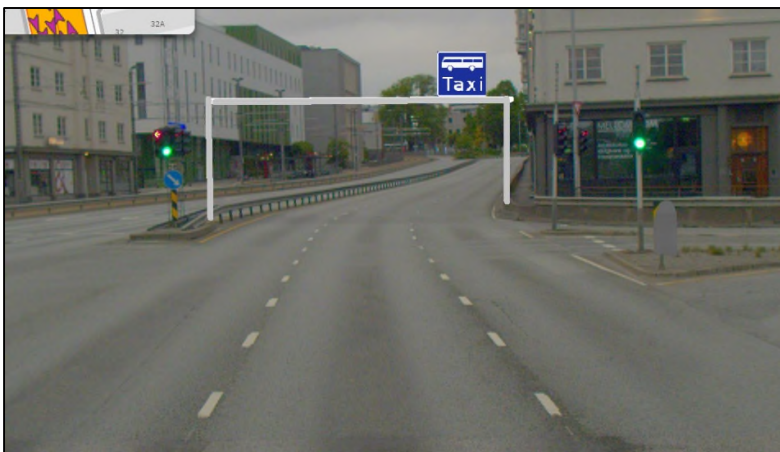
Figur 7: Skiltportal for etablering av kollektivfelt ved Danmarks plass
