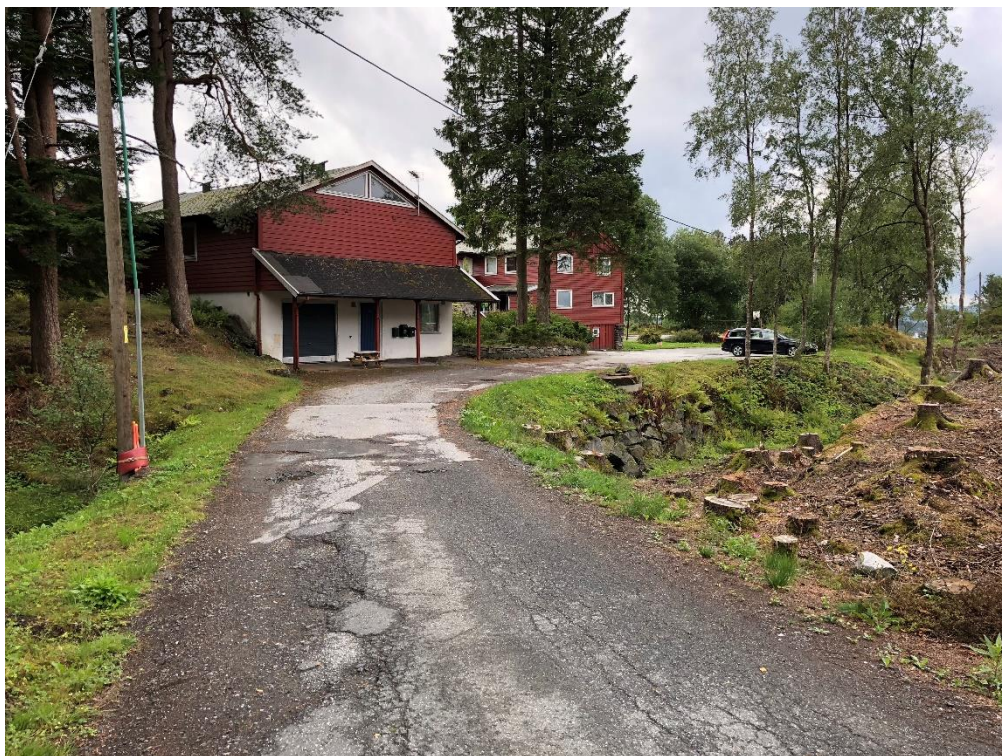
Figur 4. Adkomstveg til eksisterende bygg. Lønningsbekken er i dag i rør under vegen. Sett mot sør.
