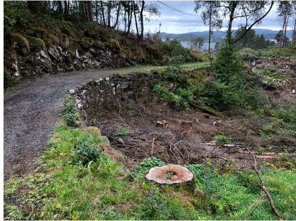
Figur 36 Mur langs turveg sett mot sørvest.
