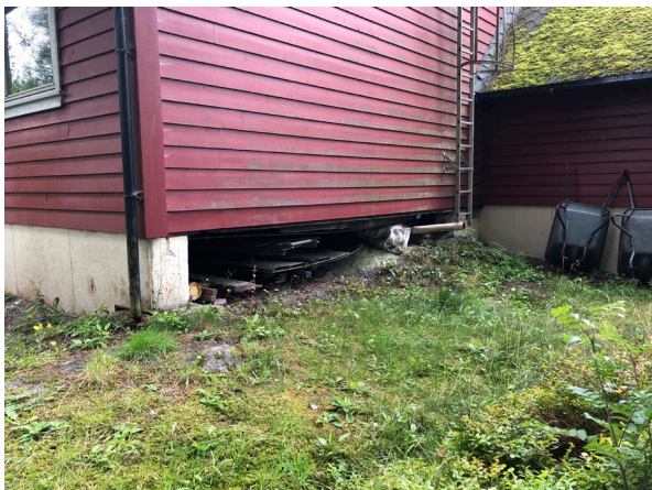
Figur 34 Overnattingsbygget står på påler. Sett mot sør.
