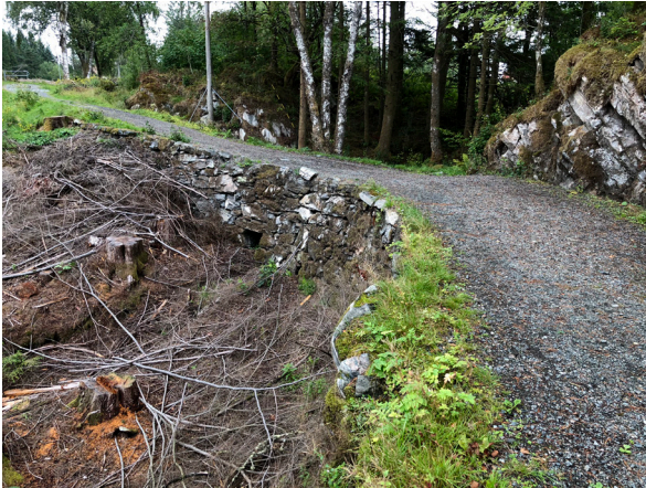
Figur 35 Mur langs turveg sett mot nordøst.
