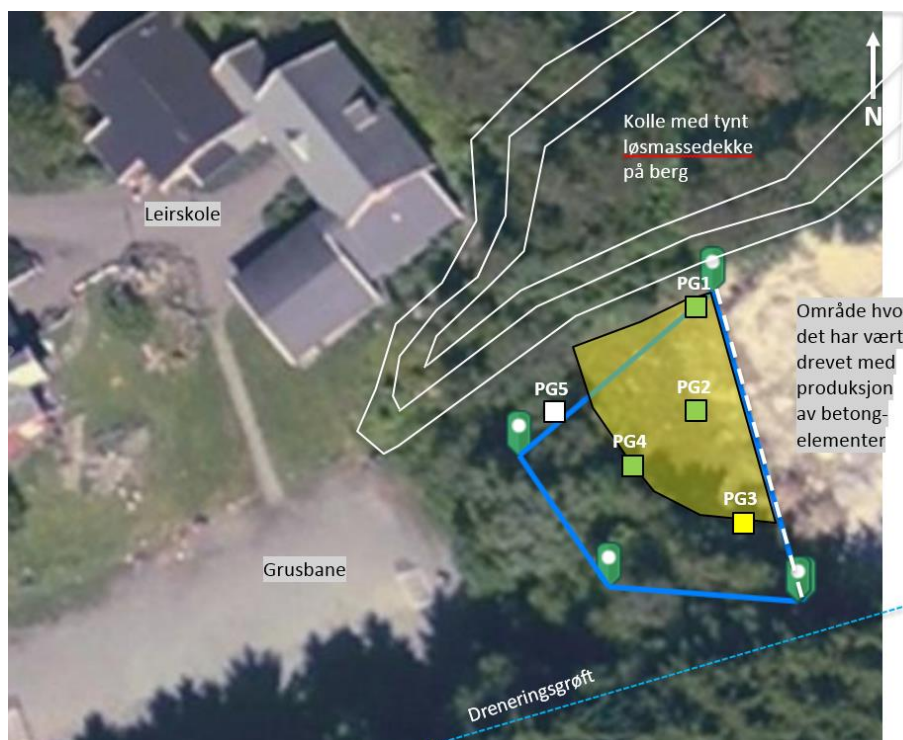
Figur 5.3: Flyfoto med omtrentlig plassering av prøvegropene (PG1–PG5) i undersøkelsesområdet (avgrenset med blå streker). Gul-skravert felt viser antatt areal hvor det ligger fyllmasser med rester av armering og betong. Foto: www.norgebilder.no .
