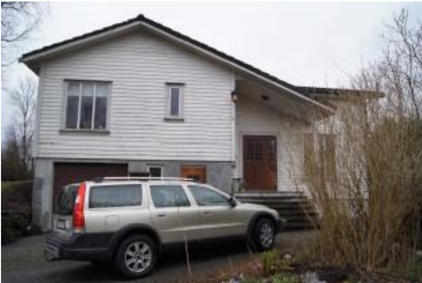
Hjortevegen 4, fasade mot aust.
