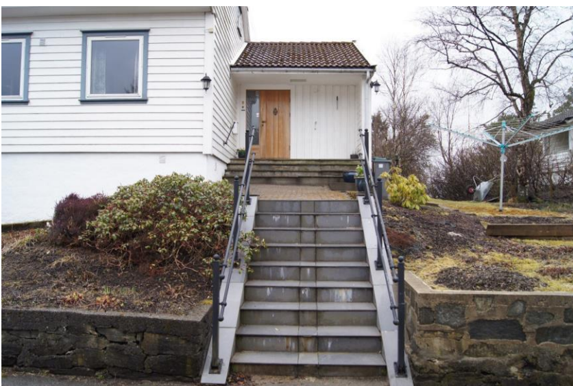
Hjortevegen 6, detalj fasade mot aust.
