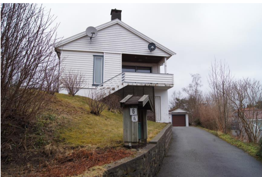
Hjortevegen 6, fasade mot sør.
