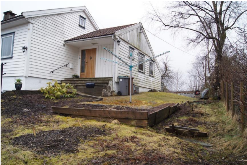
Hjortevegen 6, fasade mot nord.
