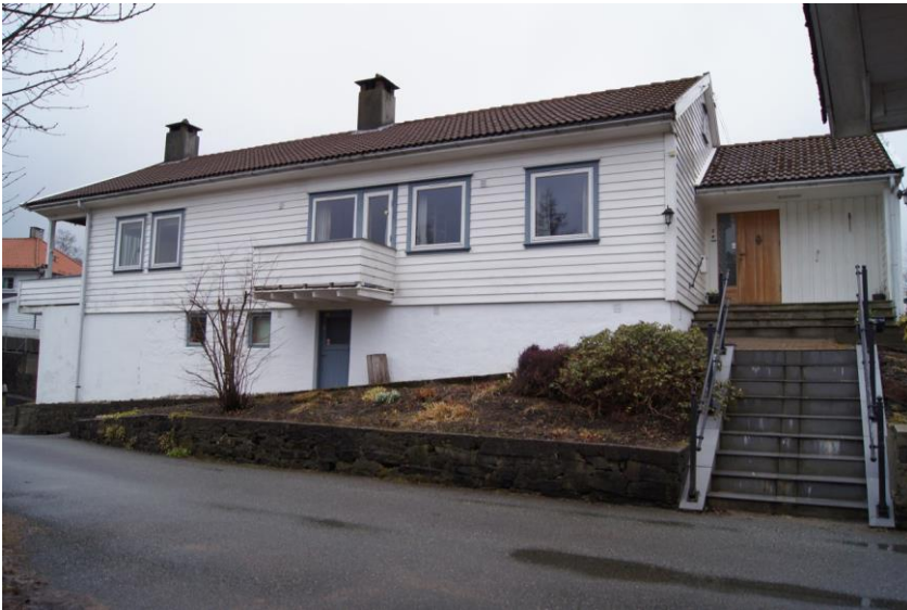
Hjortevegen 6, fasade mot aust.
