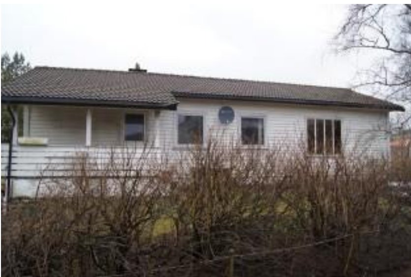
Hjortevegen 4, fasade mot sør.
