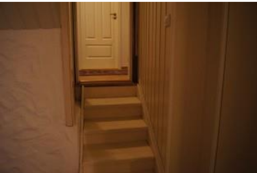
Hjortevegen 4, trapp frå kjellar til hovudetasje.
