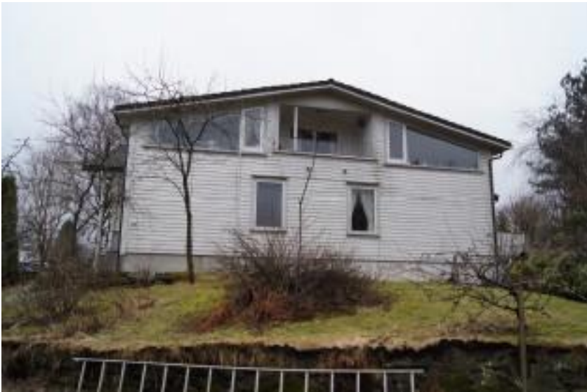
Hjortevegen 4, fasade mot nord.
