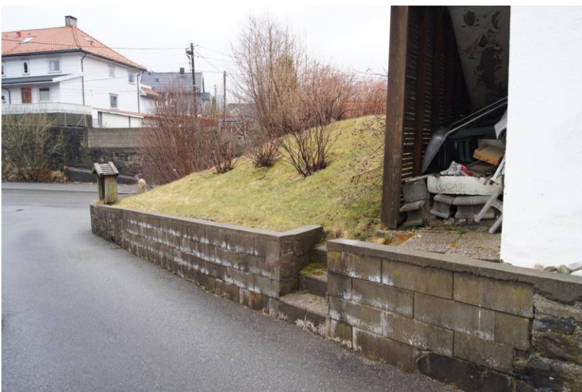
Hjortevegen 6, tilkomstveg med mur og trapp.
