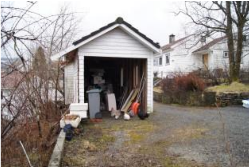
Garasje, Hjortevegen 4. Hjortevegen 6 til høyre i bildet.
