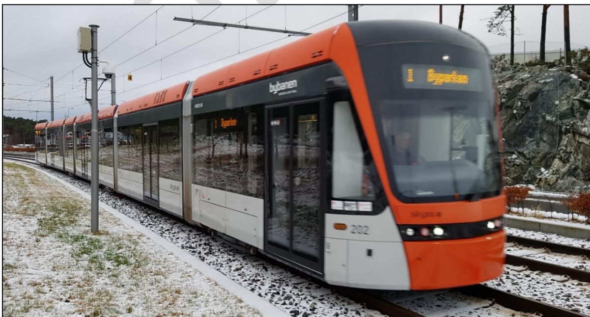
Figur 18 Bybanen mellom Bergen sentrum/Byparken og Bergen lufthavn Flesland. Foto: Opus Bergen AS.
