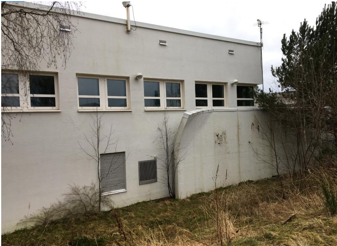
Figur 13. Fasade i nordvest.
