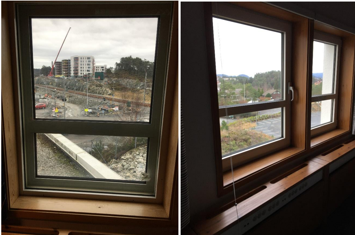
Figur 28. Bilde av skuddsikkert vindu i hovedbygg og åpningsvinduer og radiatorbrystning i sidefløy.
