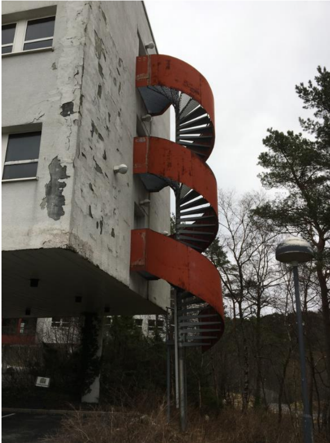
Figur 9. Utvendig vindeltrapp i øst.
