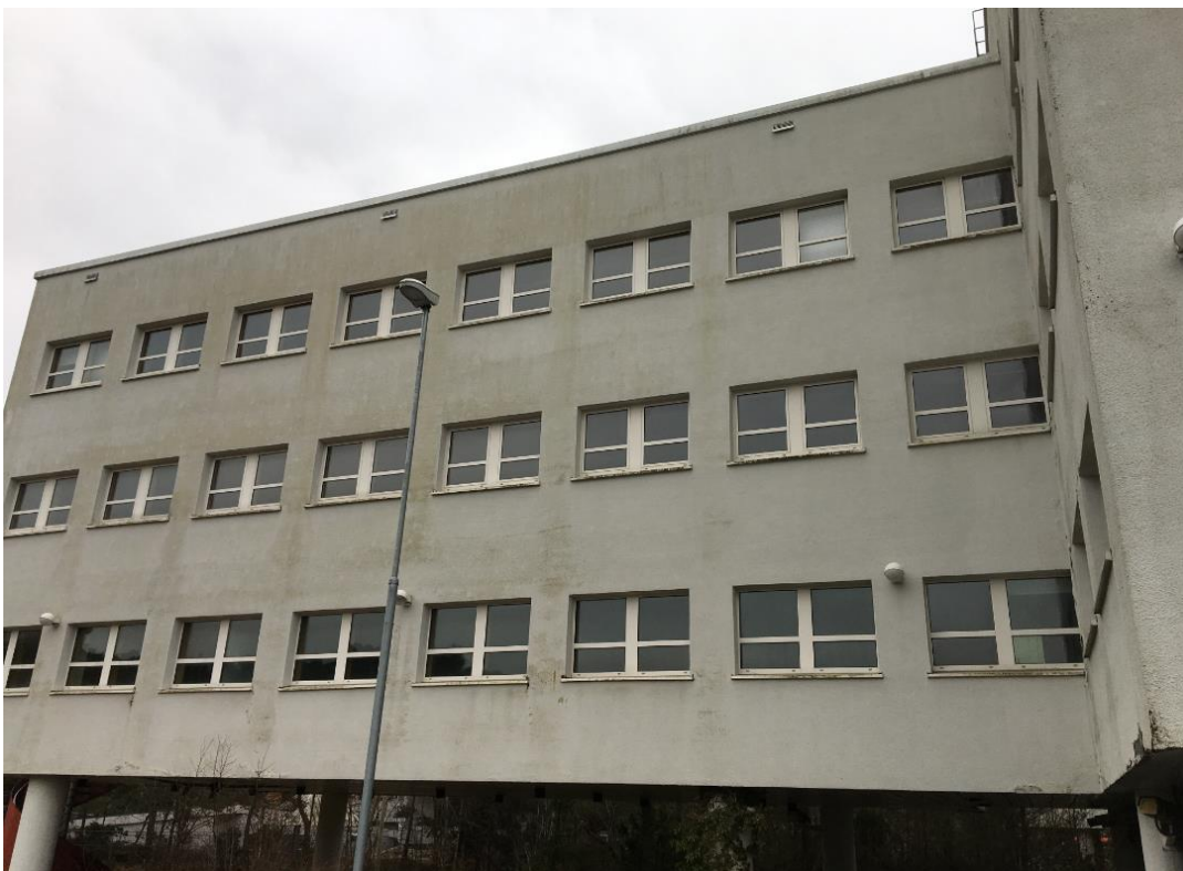
Figur 10. Kontorfløy i øst
