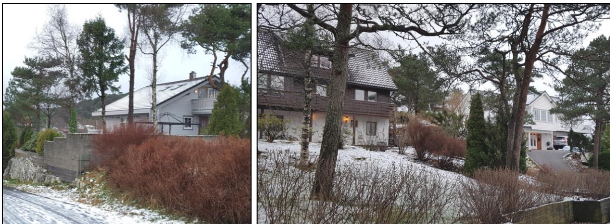
Figur 18. Øvrige boliger i Sandslieheiane er oppført på 1980-tallet. Foto: Opus Bergen AS.
