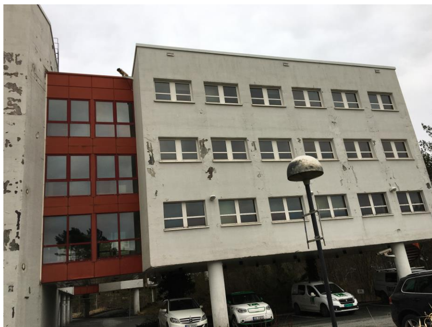
Figur 22. Fasade i øst.
