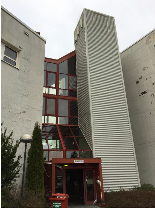
Figur 40. Heis i mellombygget.
