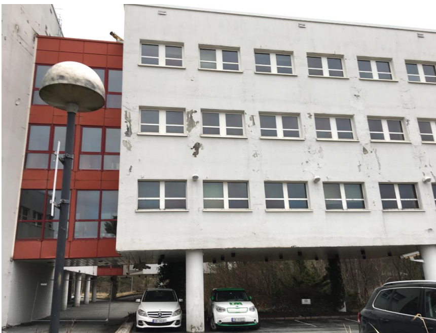
Figur 8. Kontorfløy i øst.
