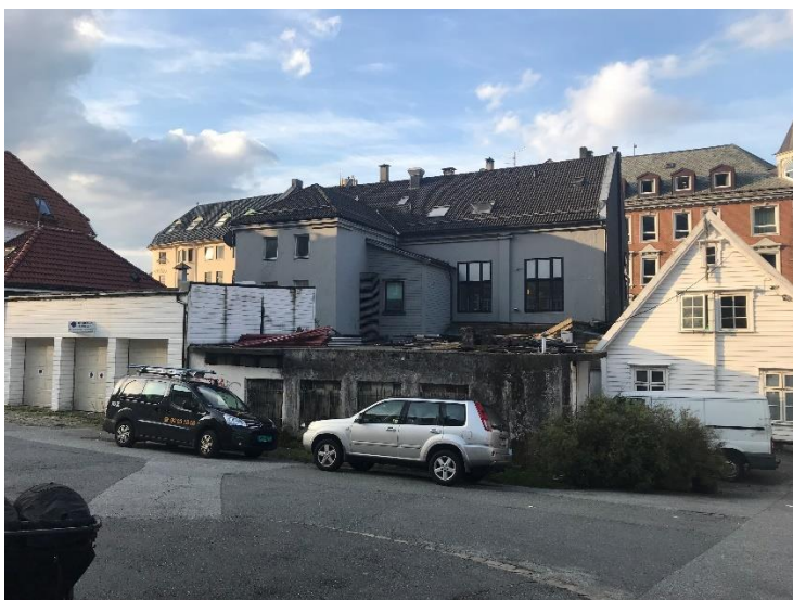
Figur 5 Kong Oscars gate 44 sett fra Asylplass. Asylplassen 3 og 5 med flate tak i forgrunnen.
