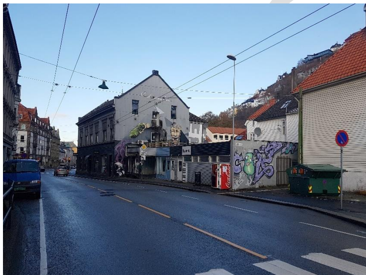
Figur 3 Kong Oscars gate 44, 46 og 48 - murhus med 2 etasjer med saltak og 1 etasjes paviljonger med flate tak. I bakgrunnen ser vi Fjellsiden.
