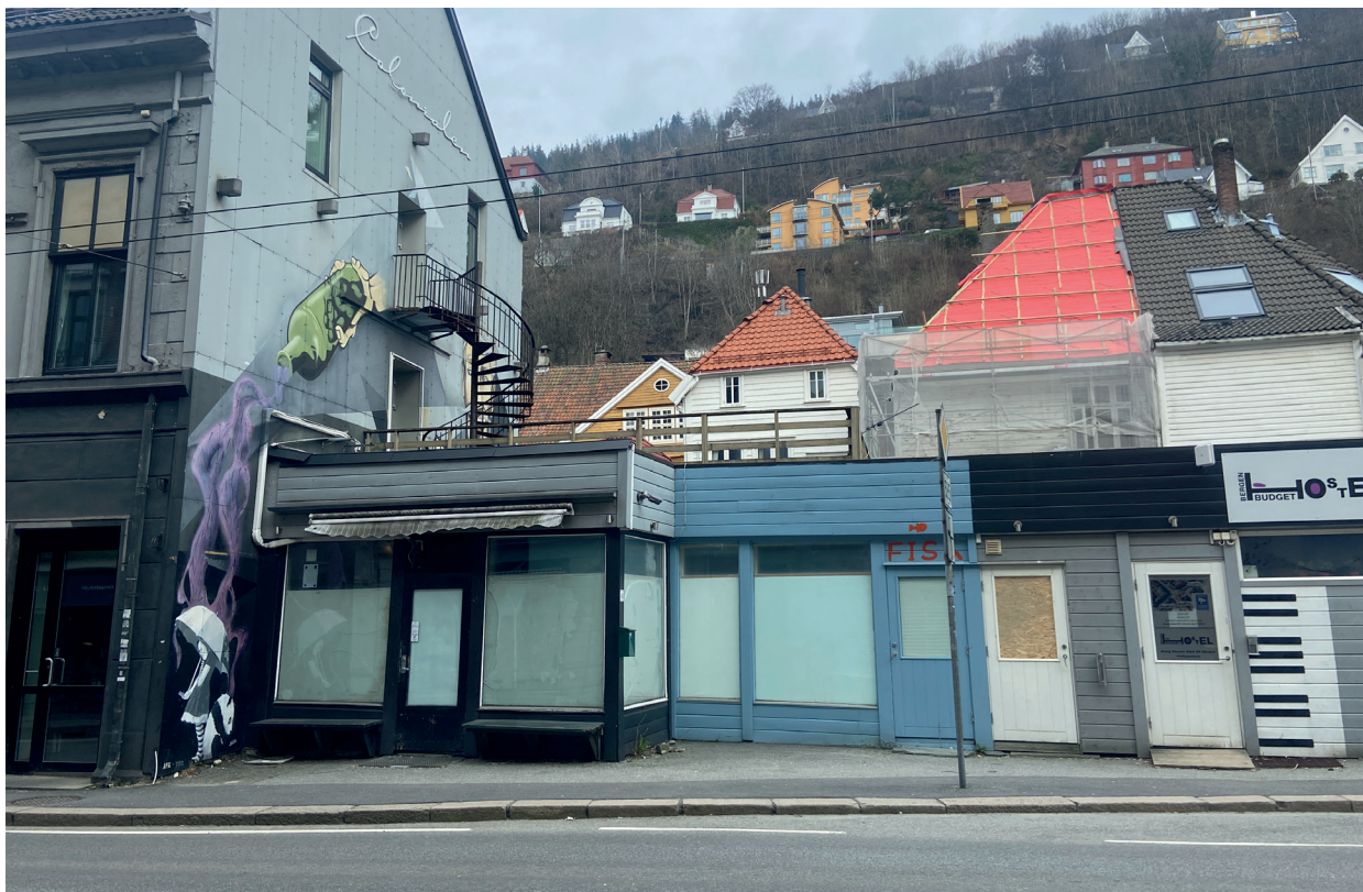
Dagens hovudfasade Kong Oscars gate. Heilt til venstre i bildet deler av fasaden på Kong Oscars gate 44, og deretter butikkpaviljongane med adresse Kong Oscars gate 46 og 48. Innvendig er det i dag open løysing mellom nr 46 og 48. Bildet er tatt frå sør.
