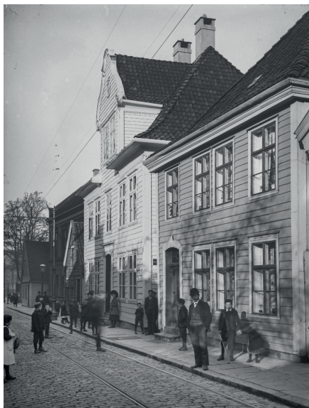
Figur 7: Bilete tidfest 1898–1905. Husrekke fra nr. 42 til venstre til nr. 50 til høyre. Foto: Ubb billedsamlingen.
