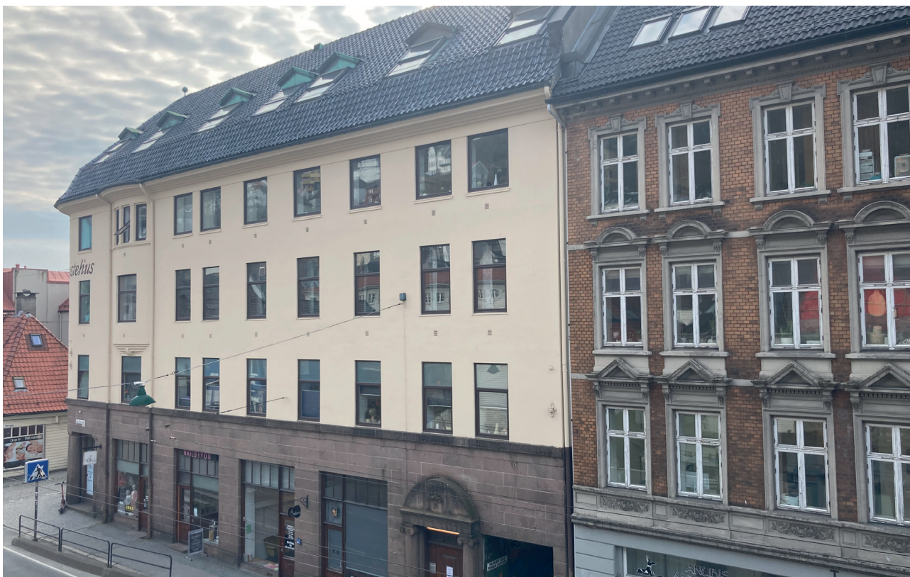
Detaljrikdom i fasadane på murbygga like over gata frå planområdet. Til venstre i bildet ser me Marken gjestehus (Kong Oscars gate 45) som har eit meir nøkternt detaljnivå enn dei fleste av den andre murbygga langs denne delen av Kong Oscars gate.
