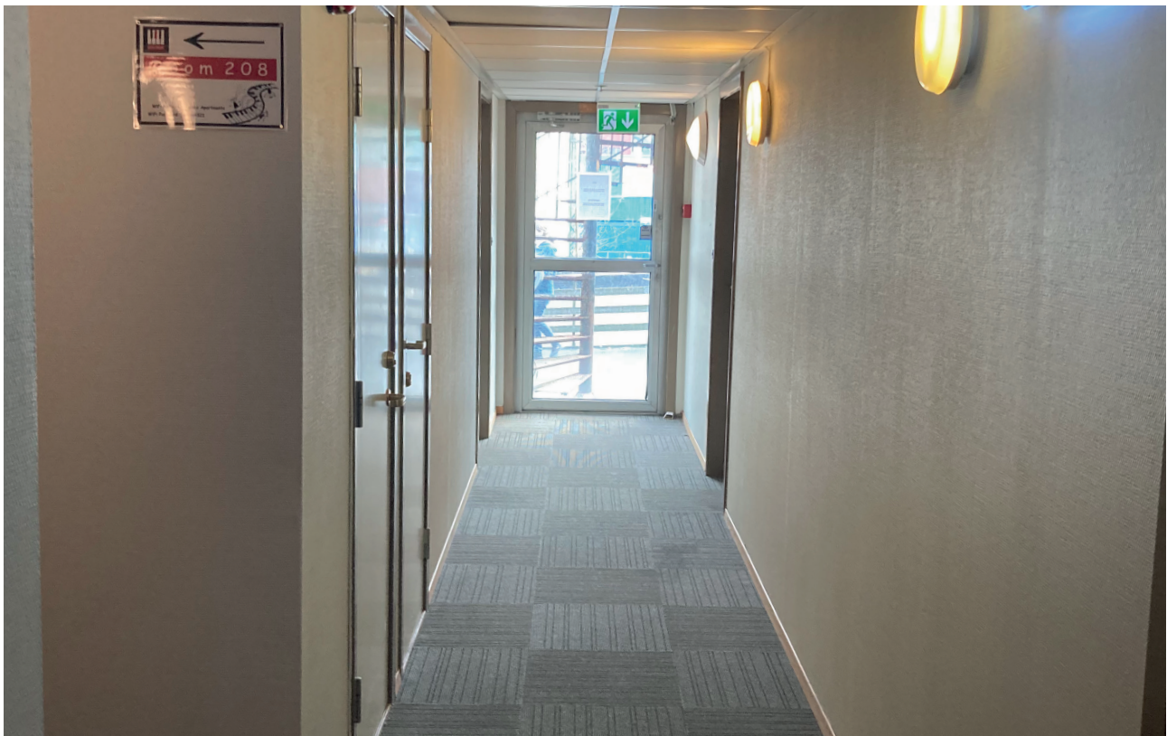
Bildene på denne sida viser hotellkorridor aust i bygget i Kong Oscars gate 44, i den delen kor nybygget er tenkt å skulle koplast på.
