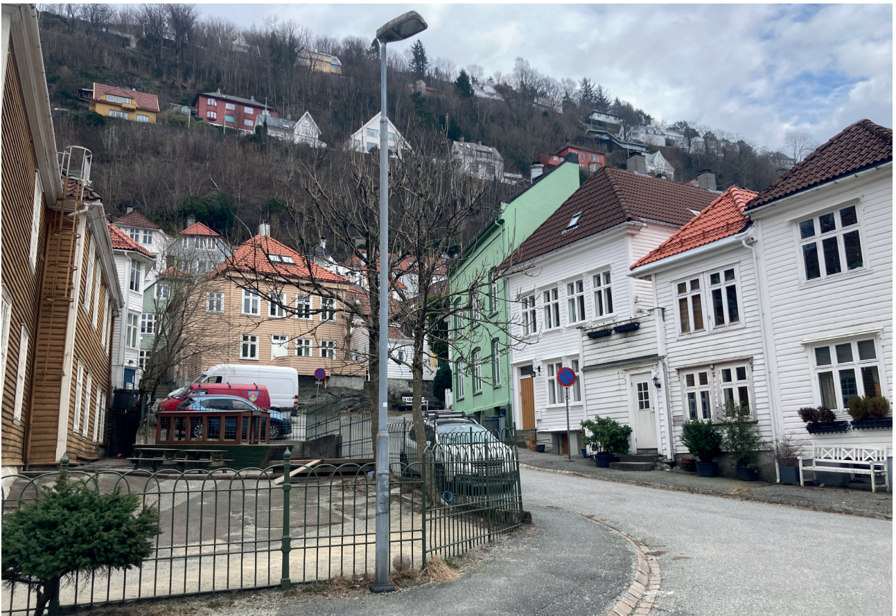
Kulturmiljø Asylplassen. Bergens barneasyl heilt til venstre i bildet.
