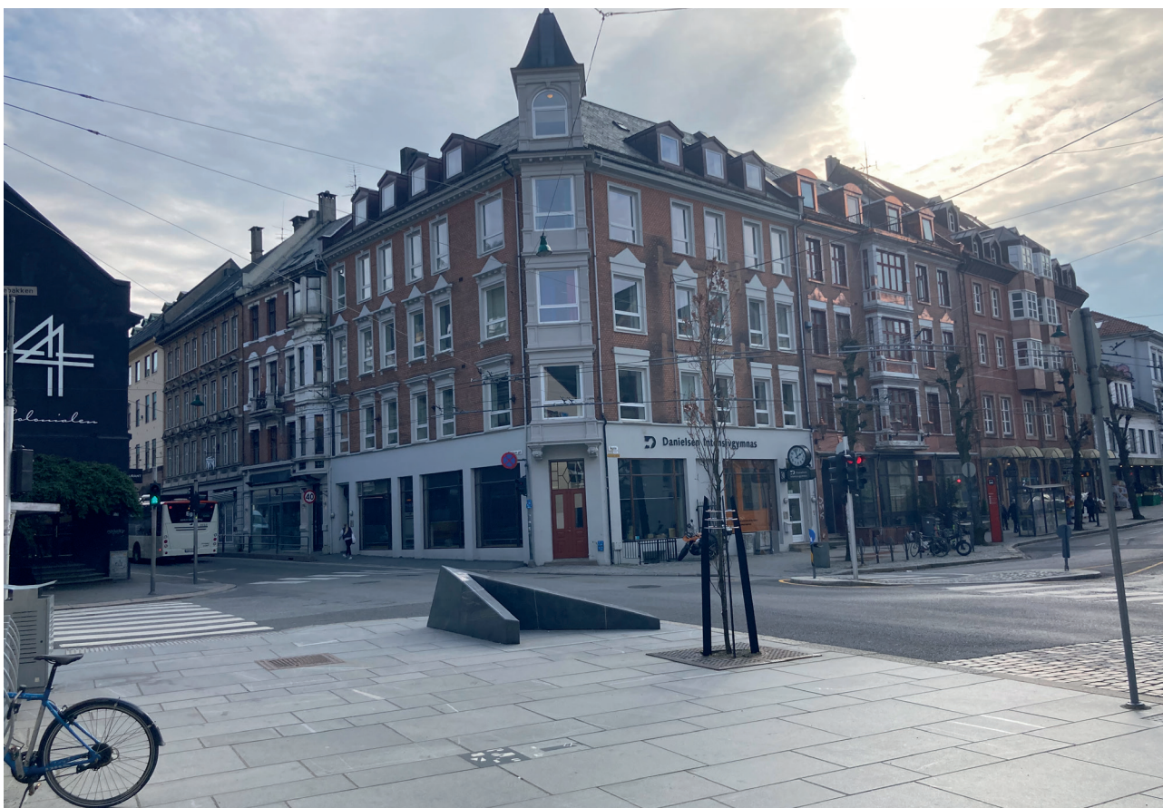
Krysset Kong Oscars gate / Nygaten. Heilt til venstre i bildet ser me Kong Oscars gate 44 i planområdet. På dette bildet får ein eit godt bilde av detaljrikdommen i murbygga i området.
