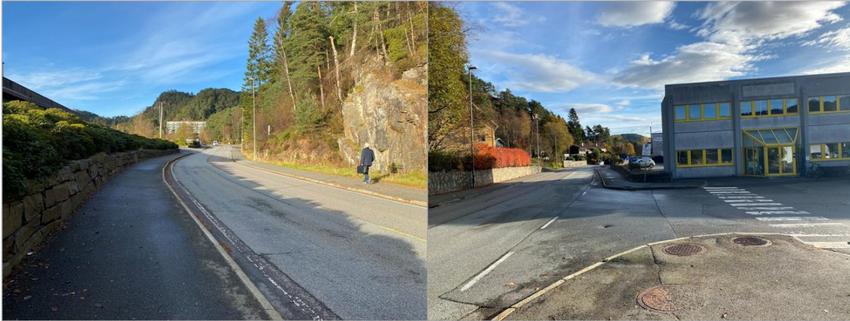
Figur 3: Til venstre: gatebilde av tilbudet i Spelhaugen. Til høyre: en av to avkjørsler som krysser fortauet på vestsiden. Kryssingen av denne avkjørselen er tilrettelagt med gangfelt (Foto: Sweco Norge).
