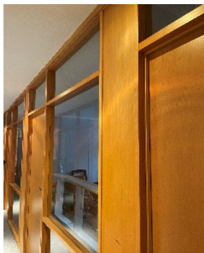
Figur 7 Bygg 2: Takbjelker, systemvegger og ståldører til ombruk
