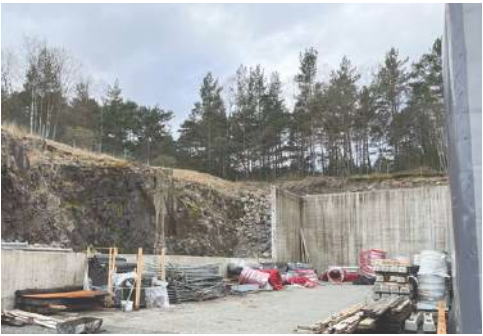
1. Eksisterende mur mot sør-vest
