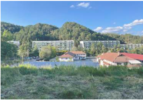
1. Eksisterende mur mot sør-vest
