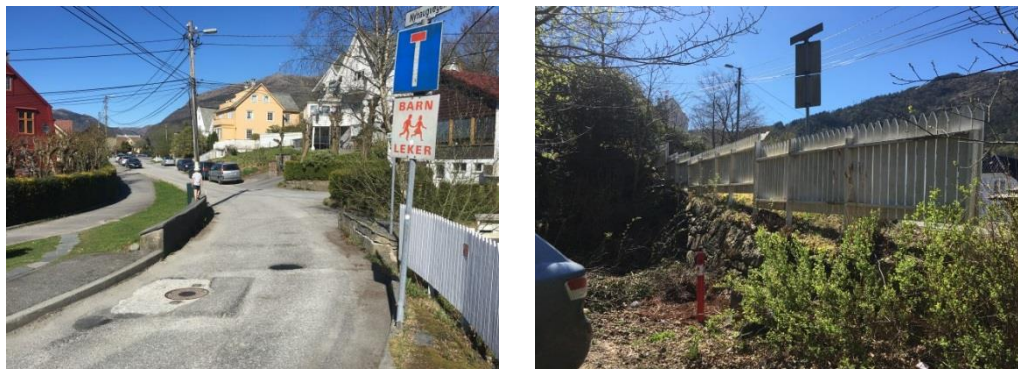
Figur 3-9 Mulig eldre brokonstruksjon over Nyhaugveien. Sweco.
