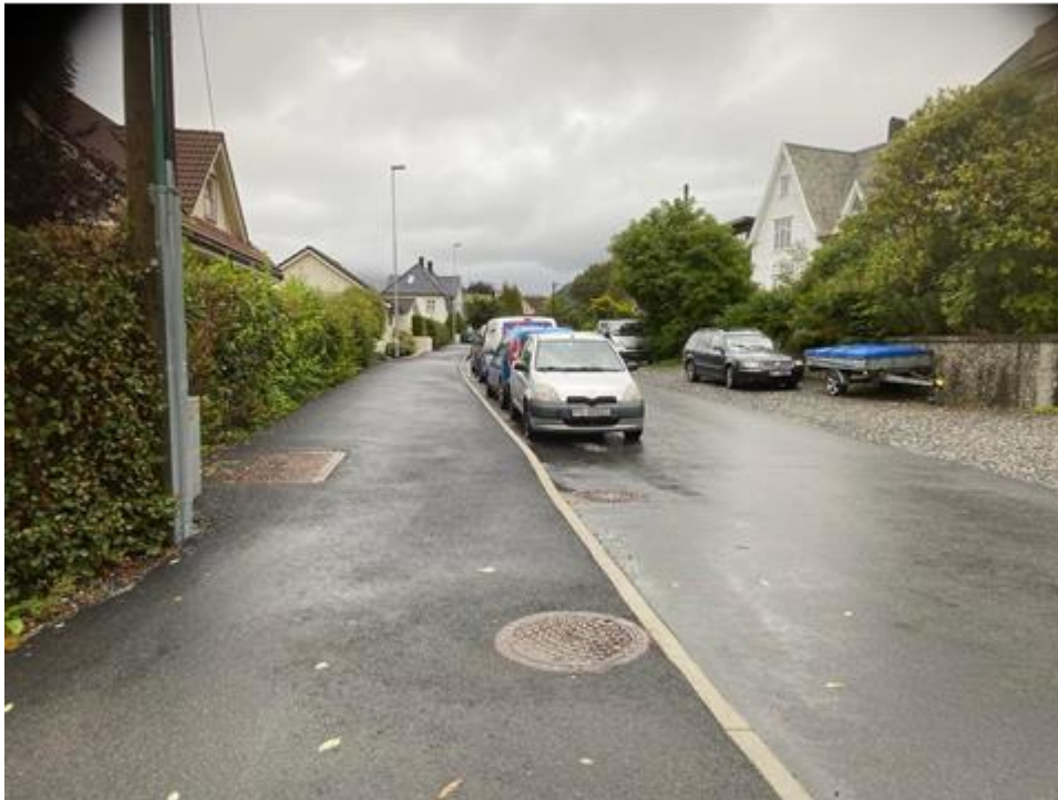
Figur 13: Nyhaugveien har etablert bredt, sammenhengende fortau for myke trafikanter.
