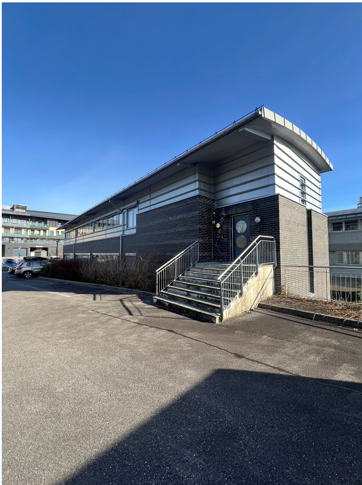
Figur 9 Bilde nr.1. Vestlig del av eksisterende bygg.
