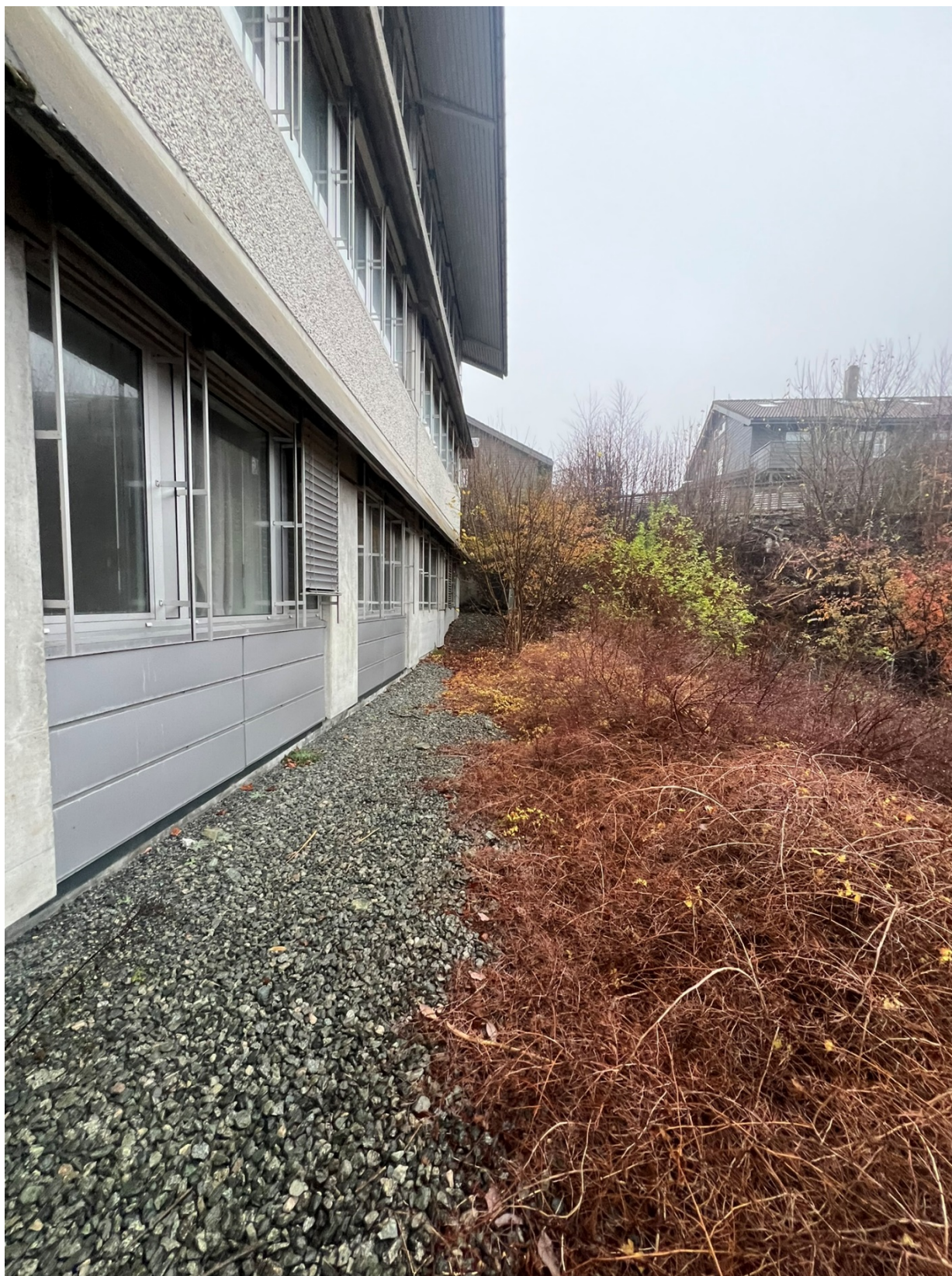
Figur 15 Bilde nr.7 Langs fasaden på østsiden av østlig bygningsmasse. Her planlegges det for en etablering av ny snarveg rundt bygget.
