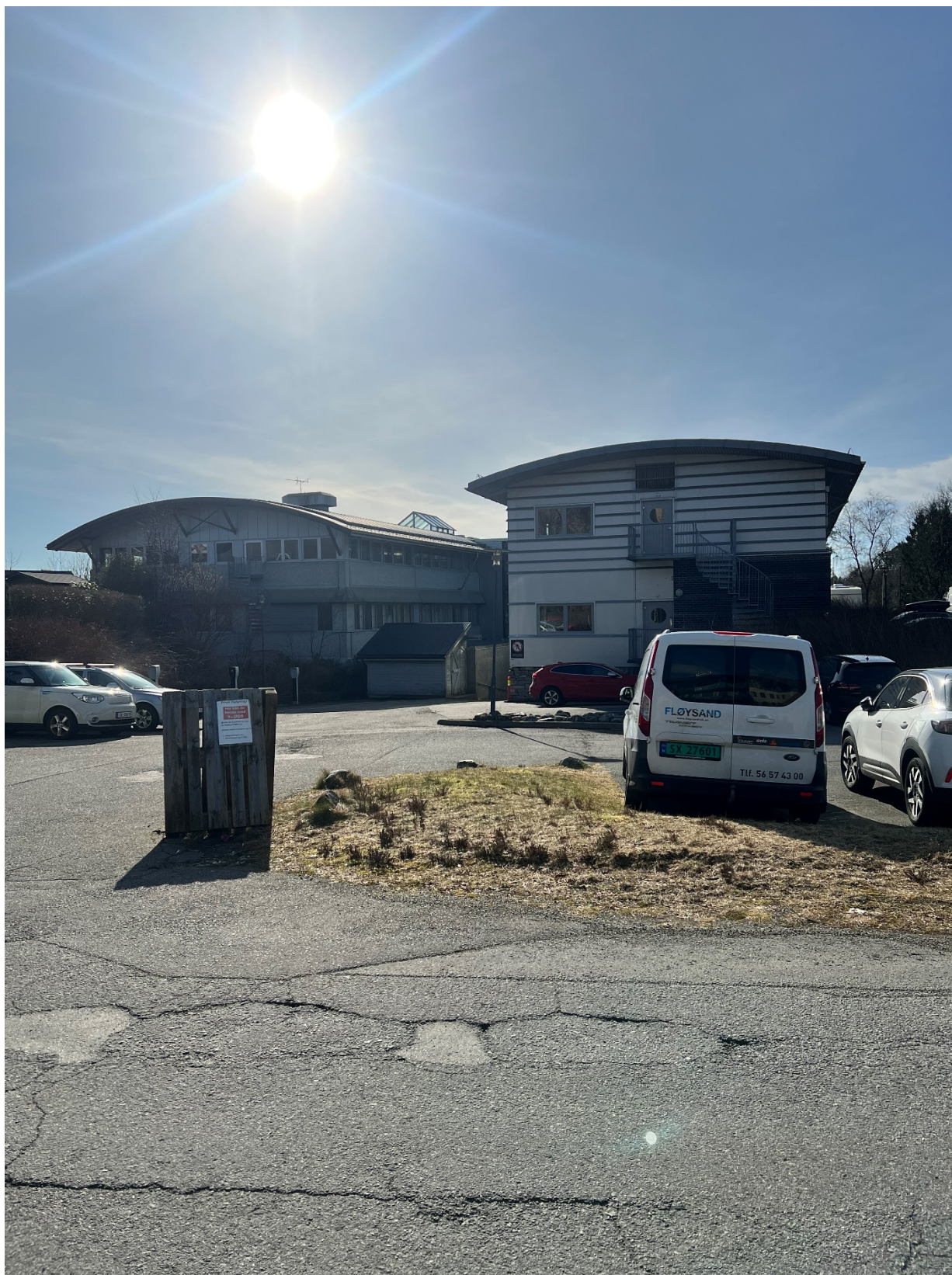
Figur 14 Bilde nr.6 Glasstak på eksisterende bygg (østlig del) som planlegges gjenbrukt i prosjektet.
