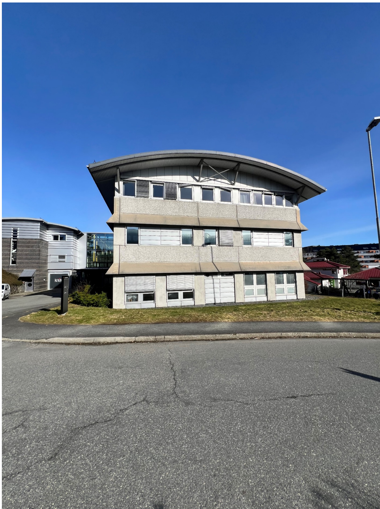
Figur 11 Bilde nr.3. Østlig bygningsmasse, hvor deler av bygningsmassen skal videreføres i prosjektet.
