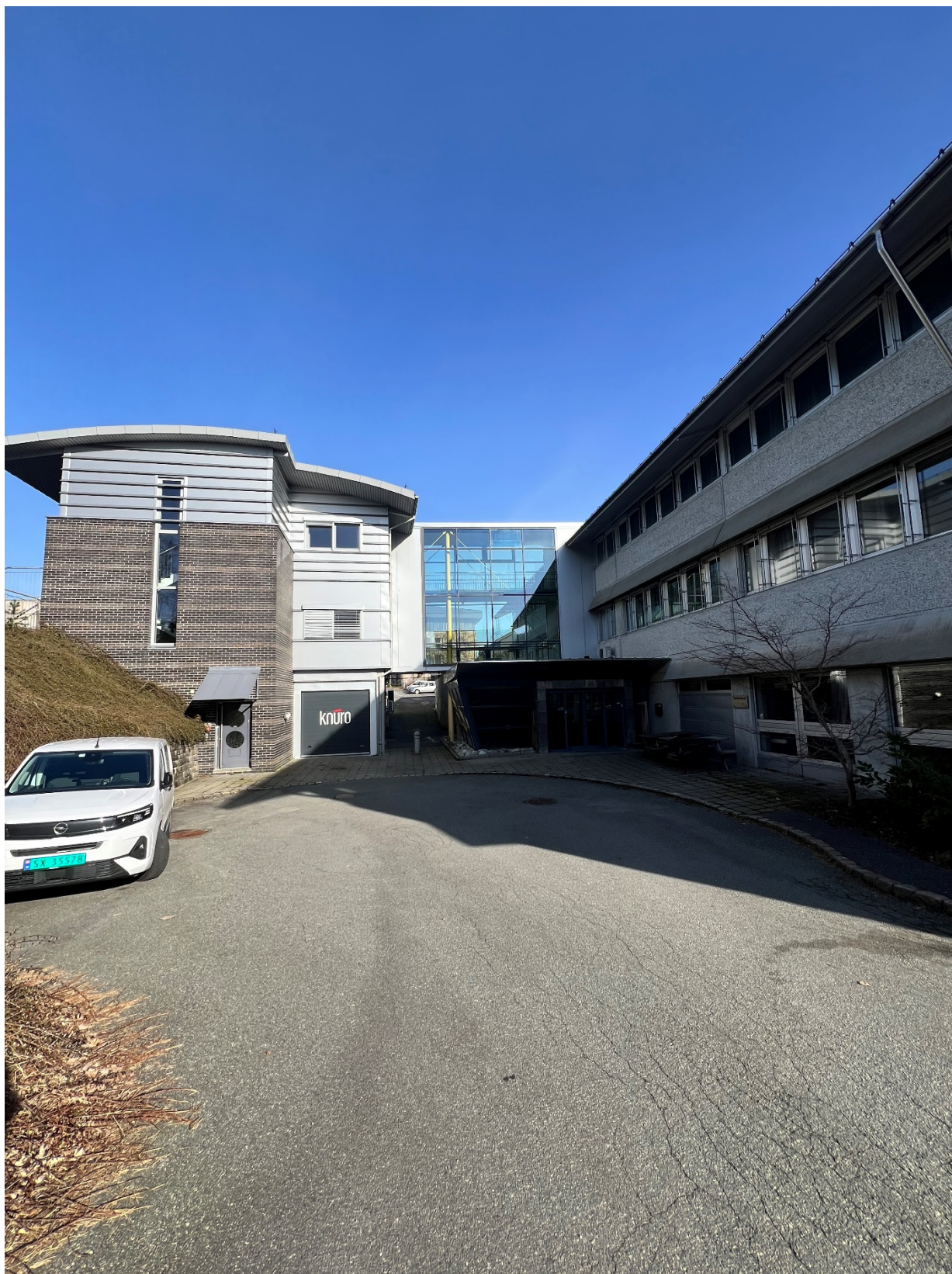
Figur 10 Bilde nr.2. Gangbro mellom de to bygningsmassene. Under gangbroen er det i dag en gangforbindelse, denne skal videreføres i planforslaget.
