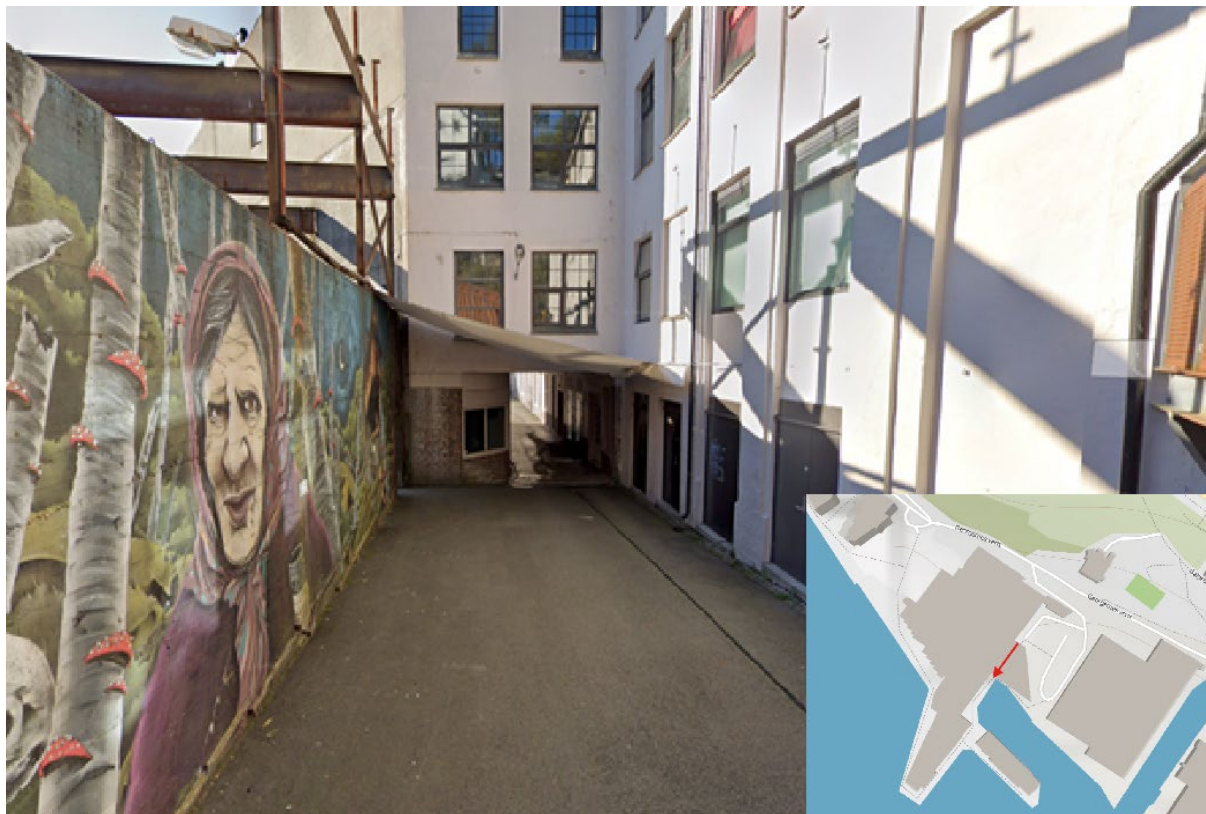
Figur 3 - Bilde av undergang i eks. USF-bygg.
