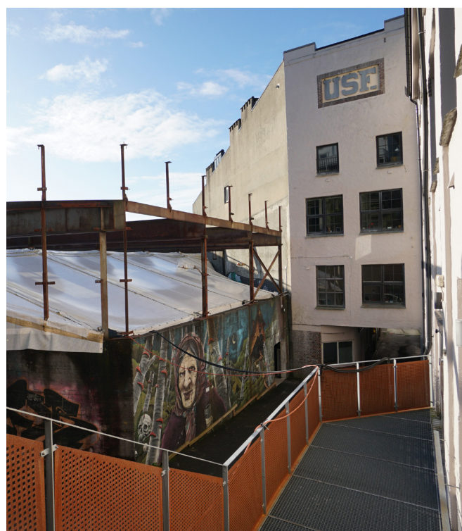
Bilde 11. Overgangen fra USF byggene til Kjødehallene. Foto Ida Wressel, Vill Arkitektur, Dato 19.10.2023
