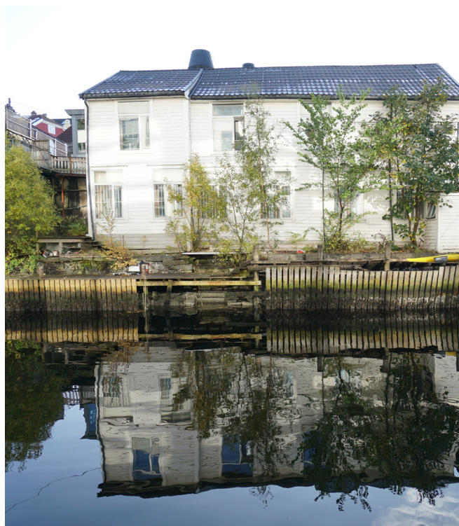
Bilde 29. Dokkhuset langs østlig side av dokken, nordlig del av Dokkhuset er borte - Foto Ida Wressel, Vill Arkitektur, 05.10.2023
