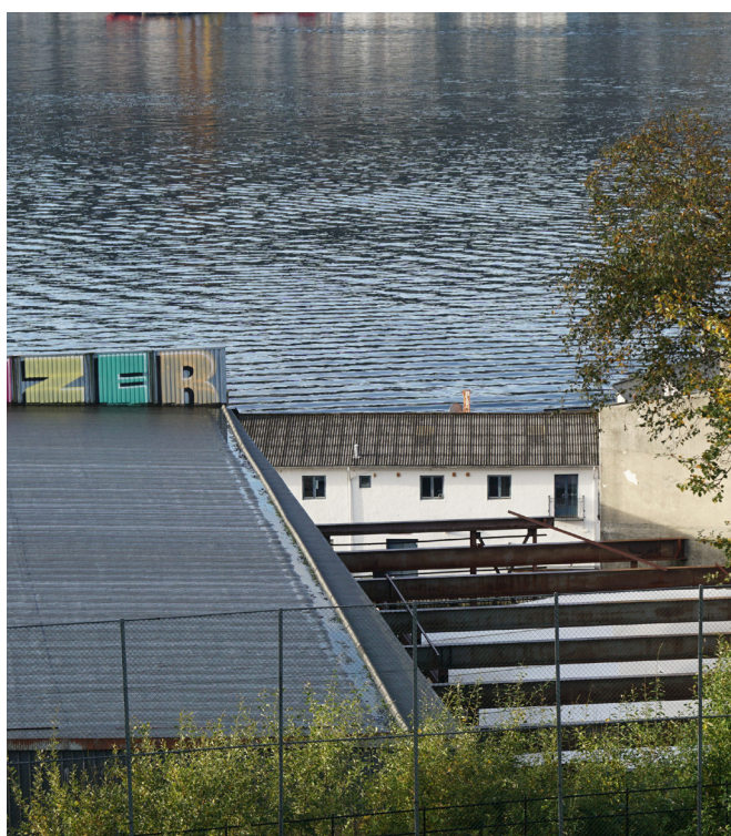
Bilde 19. Oversiktsbilde Dikkedokken, overgang fra papptak til åpen stålkonstruksjon, Foto Ida Wressel, Vill Arkitektur, 05.10.2023
