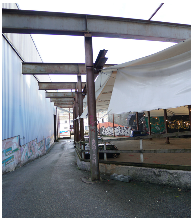
Bilde 23. Foto av stålkonstruksjon til den 4e Kjødehallen - Foto Ida Wressel, Vill Arkitektur, 05.10.2023
