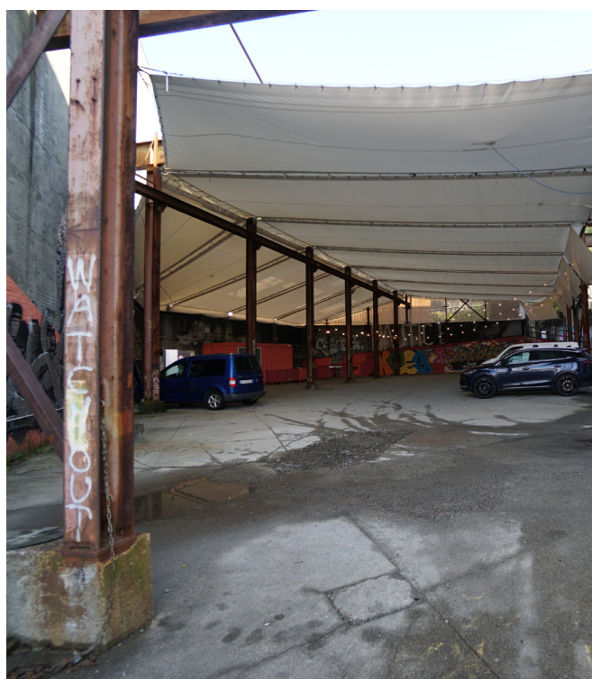
Bilde 24. Foto av stålkonstruksjon til den 4e hallen dekket med duk og parkering under - Foto Ida Wressel, Vill Arkitektur, 05.10.2023
