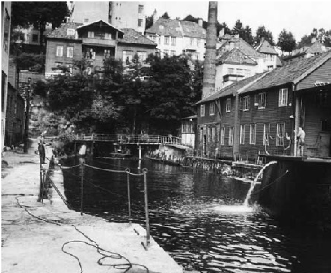
Bilde 3. Dikkedokken og Dokkhuset med pipe 1957. Billedsamlingen UiB. Foto: Olai Schumann Olsen
