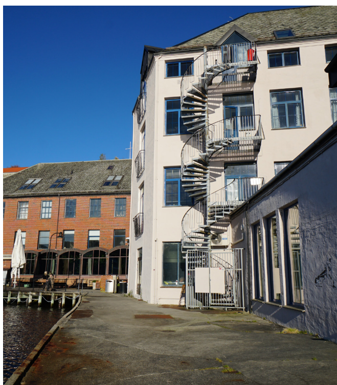
Bilde 10. USF Verftet med de ulike bygningskroppene og lavere tilbygg mot sjøen. Foto Ida Wressel, Vill Arkitektur, Dato 19.10.2023
