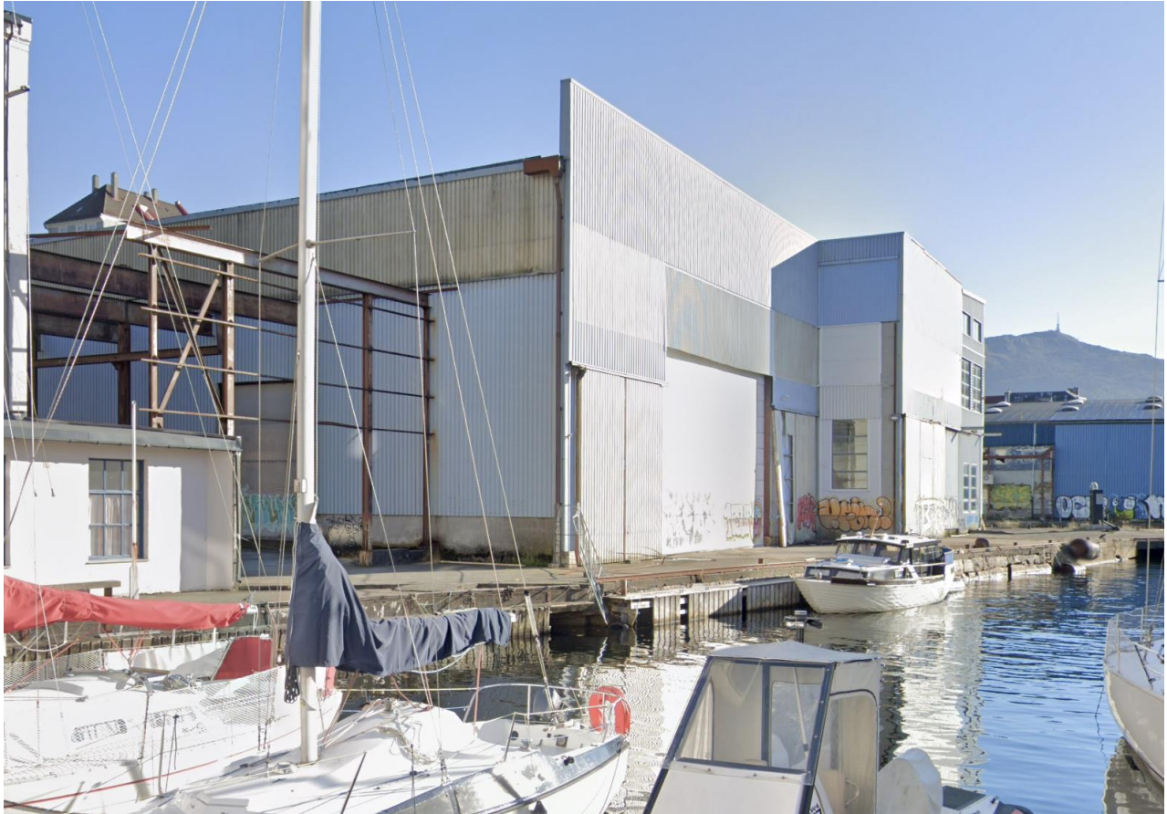
Figur 2 Kjødehallene sett fra vest. Foto fra Google Street View, okt. 2020.
