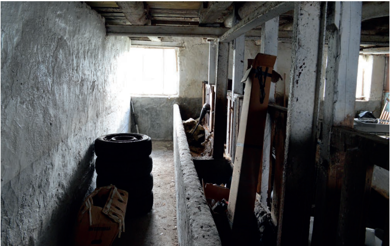
Kjellaretasjen nord i bygget. Gamal innreiing etter husdyrhald.
