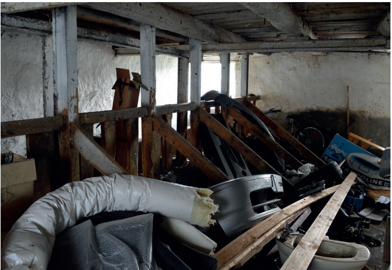
Kjellaretasjen nord i bygget. Gamal innreiing etter husdyrhald.
