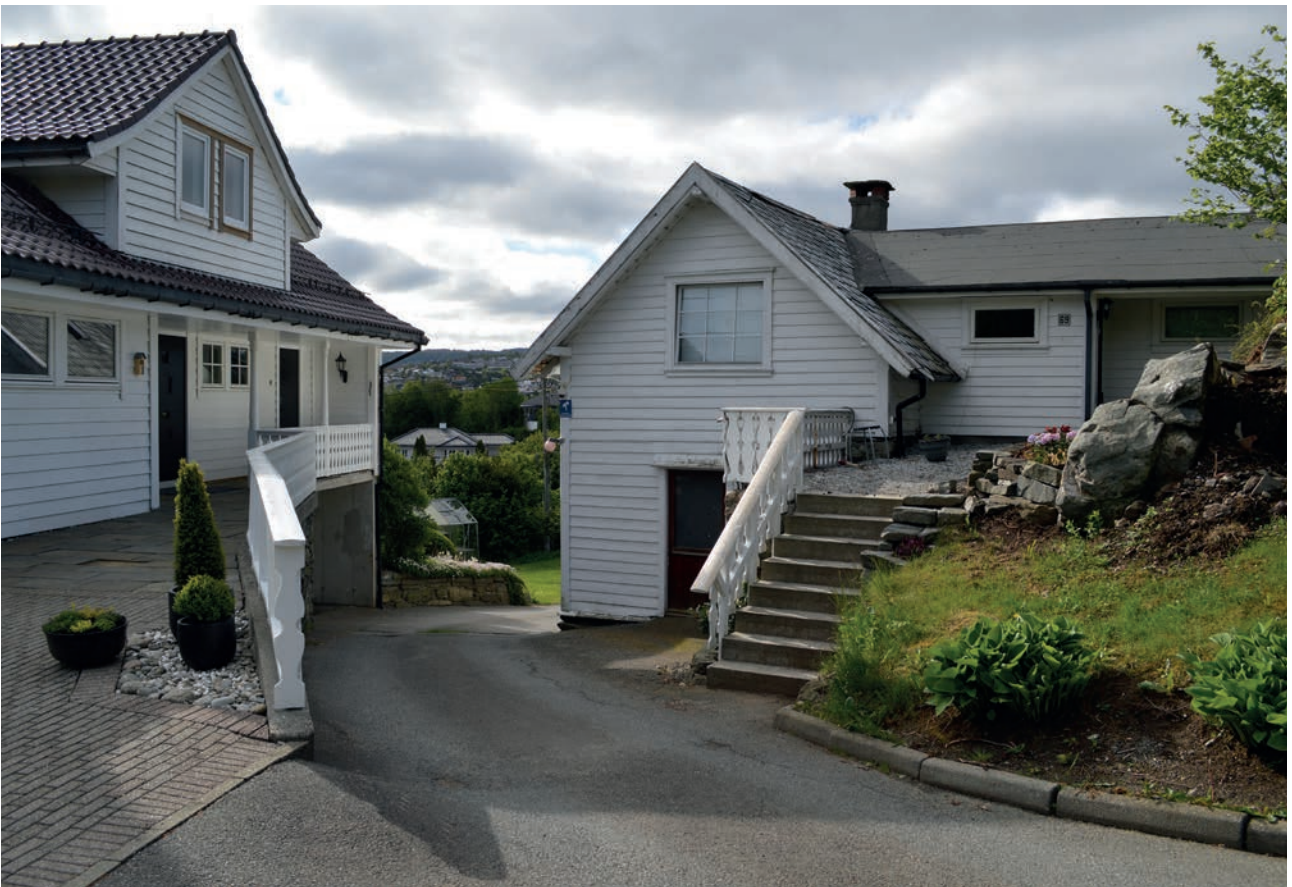
Huset til høgre er våningshus 2. Her ser ein fasade mot nord, og deler av tilbygget frå 1980-åra mot vest. Vindauga på gavlvæggen er nytt, og det er usikkert om det har vore dør her tidlegare eller ikkje. På denne sida er her skifer på taket også mot vest.
