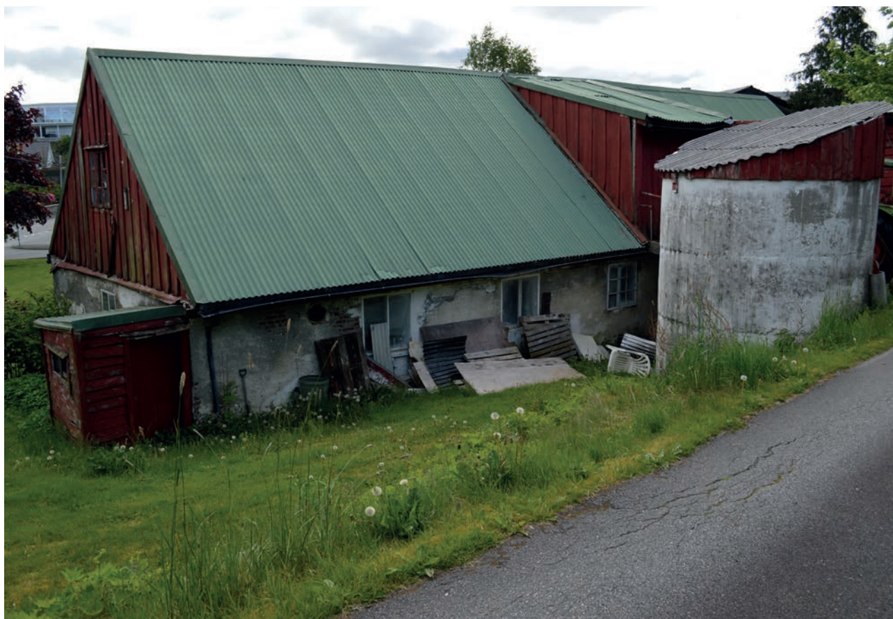
Til venstre ser ein fasade mot nord, i tillegg til nordre del av fasade mot vest og den andre av siloane. Dette er den nyare delen frå tidleg 1900-tal. Eit av vindauga her ser ut til å vera originale (det heilt til høgre).
