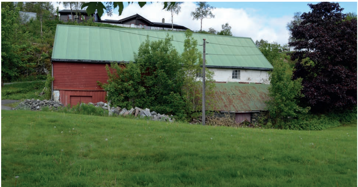
Fasade mot aust. Her ser ein tydeleg dei to byggetrinna. Til venstre med bordkledning er den eldre delen frå 1884–1888, til høgre den nyare delen i murpuss frå tidleg 1900-talet med gjødselskummen. Vindauga kan sjå ut til å vera originale.
