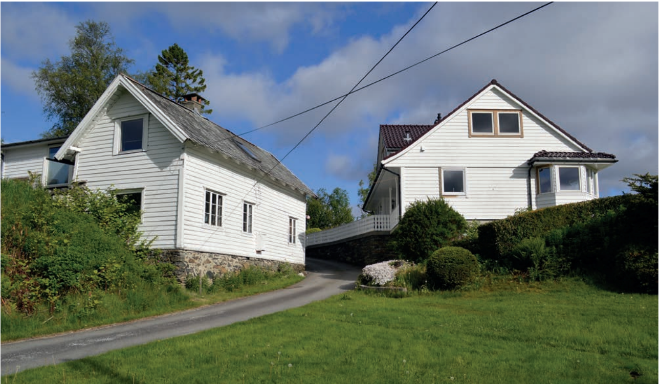
Huset til venstre er våningshus 2, og viser fasadar mot sør og aust. På fasaden mot aust (langveggen) ser ein framleis originale detaljar – vindauger og tak med skifer. På gavlvegg mot sør er vindauga skifta ut.
