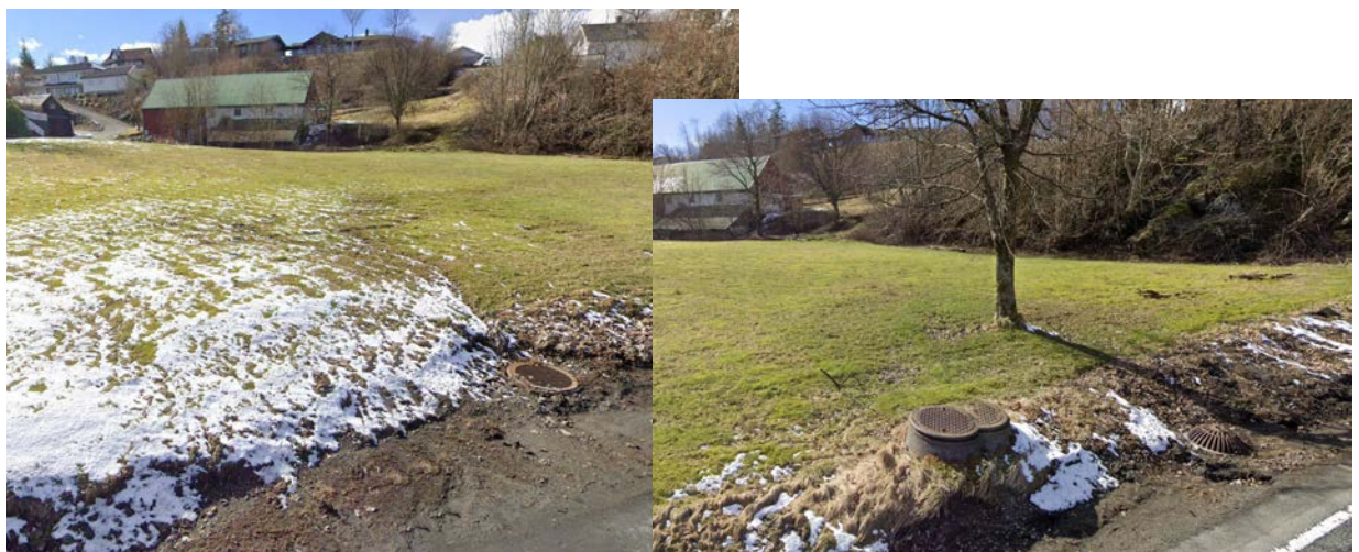
Fig. 6. To sluk langs fylkesvegen som tar imot noko avrenning fra utbyggingsområde .
