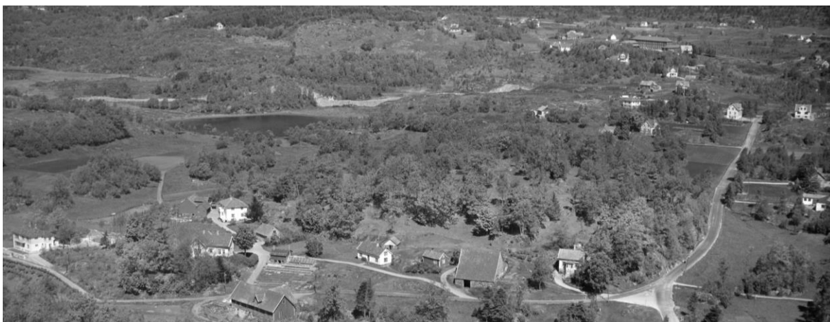
Figur 3-23: Utsnitt fra flyfoto fra juni 1955 viser planområdet bak den eldre gårdsbebyggelsen, hovedtunet på Ådland. Ny omkjøringsvei skal gå fra Hjellestadvegen til høyre i bildet, bak Vestratjørna, over til Fleslandsvegen som vi ser under bygging i bakkant av bildet. På venstre side av Hjellestadvegen ser vi Hjellestadvegen 27.
