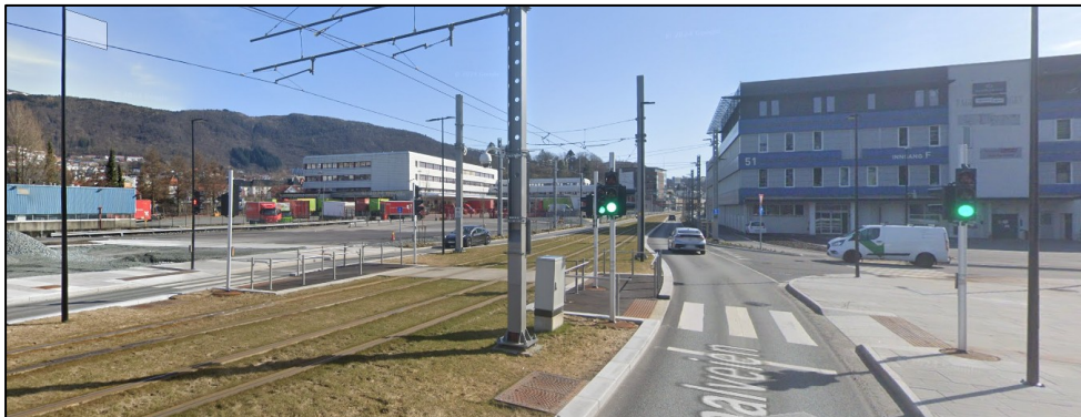
Figur 8 Overgangen nord for Mindemyren S14 og S16 («PLO nord»). Bilde er rettet mot Sør. Hentet fra Google Maps.
