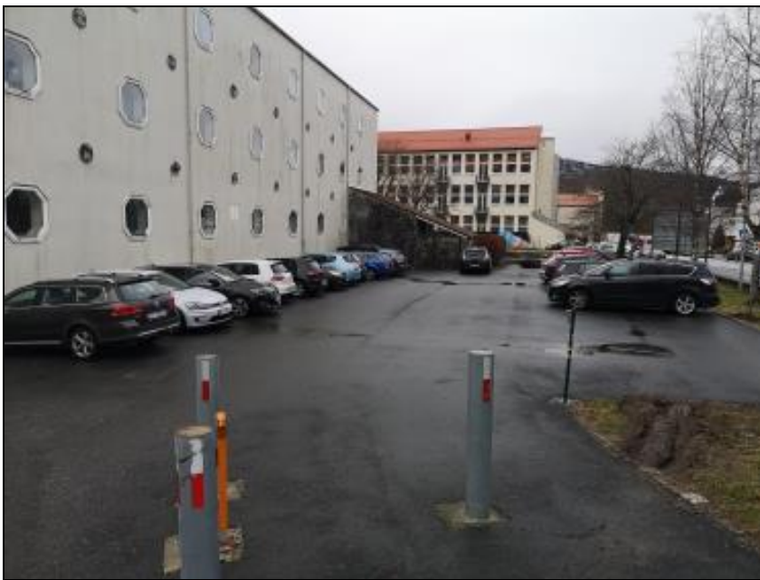
Figur 12. Parkeringsområdet utenfor Landåsveien 33 – dagens situasjon.
