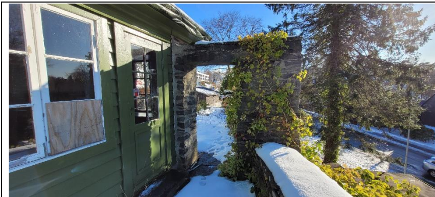
Oppmurt portal på vestre side av bygningen.
