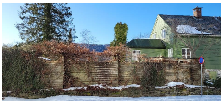
På østsiden av hagen er det oppført en betongmur.
