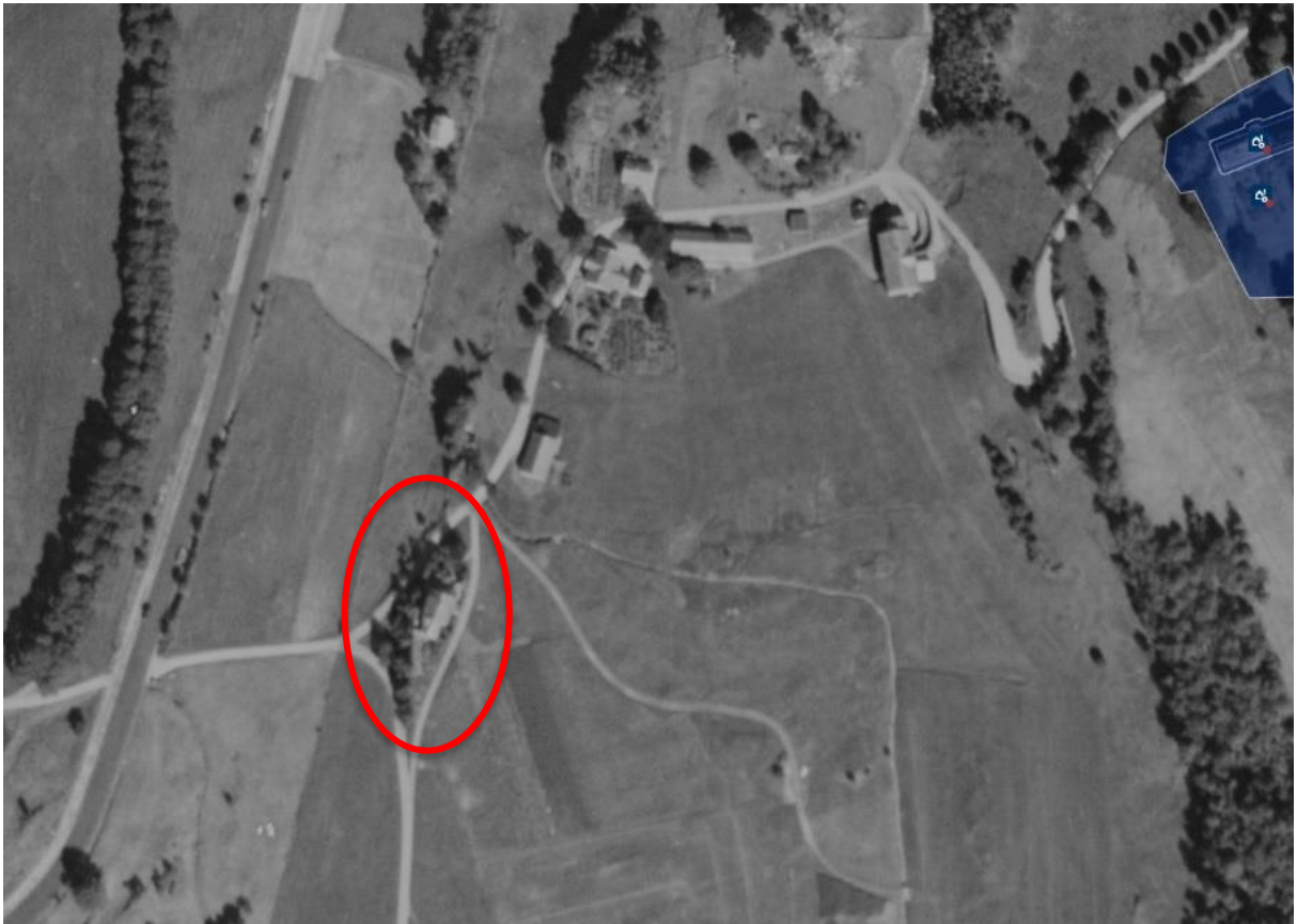
III. 4-8 Oversiktsbilde fra 1948.
