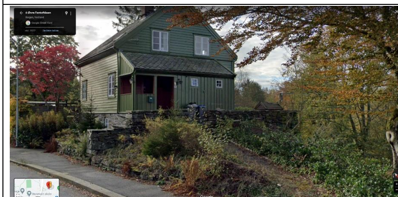
Inngangsparti fasade nord.
