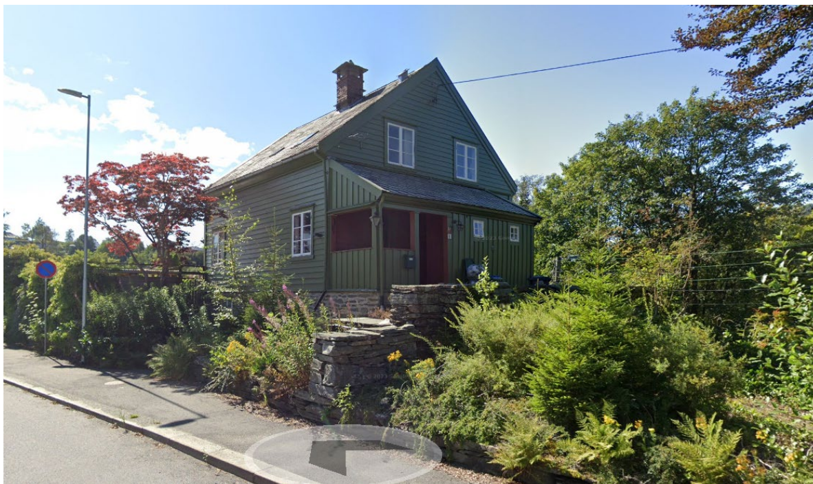
Figur 3: Skråfoto av eksisterende bolig sett fra nord-øst (veg Øvre Fantoftåsen). Kilde Google Maps.
