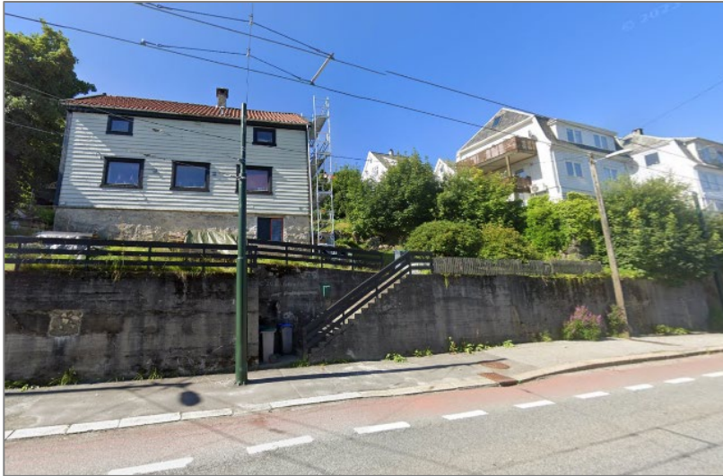
Figur 43. Bildet viser eksisterende trapp fra Kringsjåveien 10 til fortau i Kringsjåveien. Denne trappen skal utbedres og bli en del av planlagt ny gangforbindelse til Lille Damsgårdsveien, Stadionveien og Nygjerdet.
