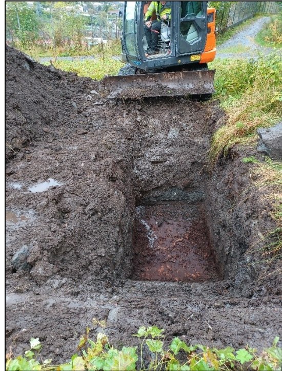
Figur 25. Sjakt 10. Foto mot N.
