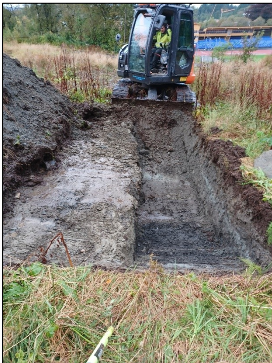
Figur 26. Sjakt 11. Foto mot N.
