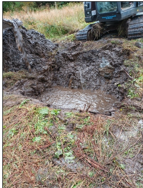
Figur 27. Sjakt 12. Foto mot SA.
