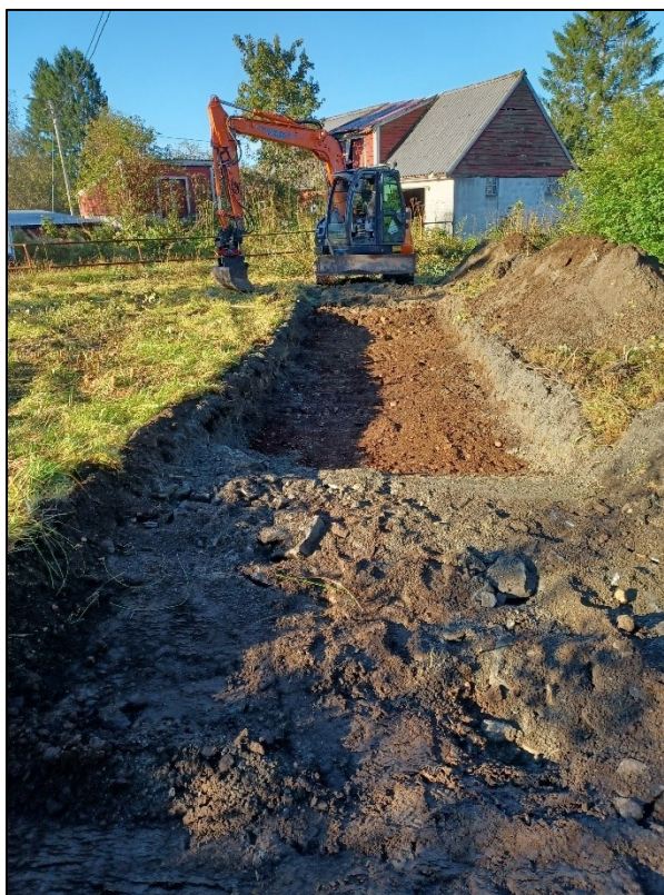
Figur 16. Sjakt 1. Foto mot SV.
