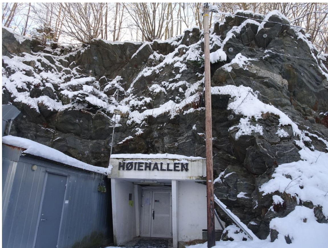
Figur 4. Inngang til Høiehallen i vestlig del av nordvendt bergskjæring. Bilde tatt mot sør.
