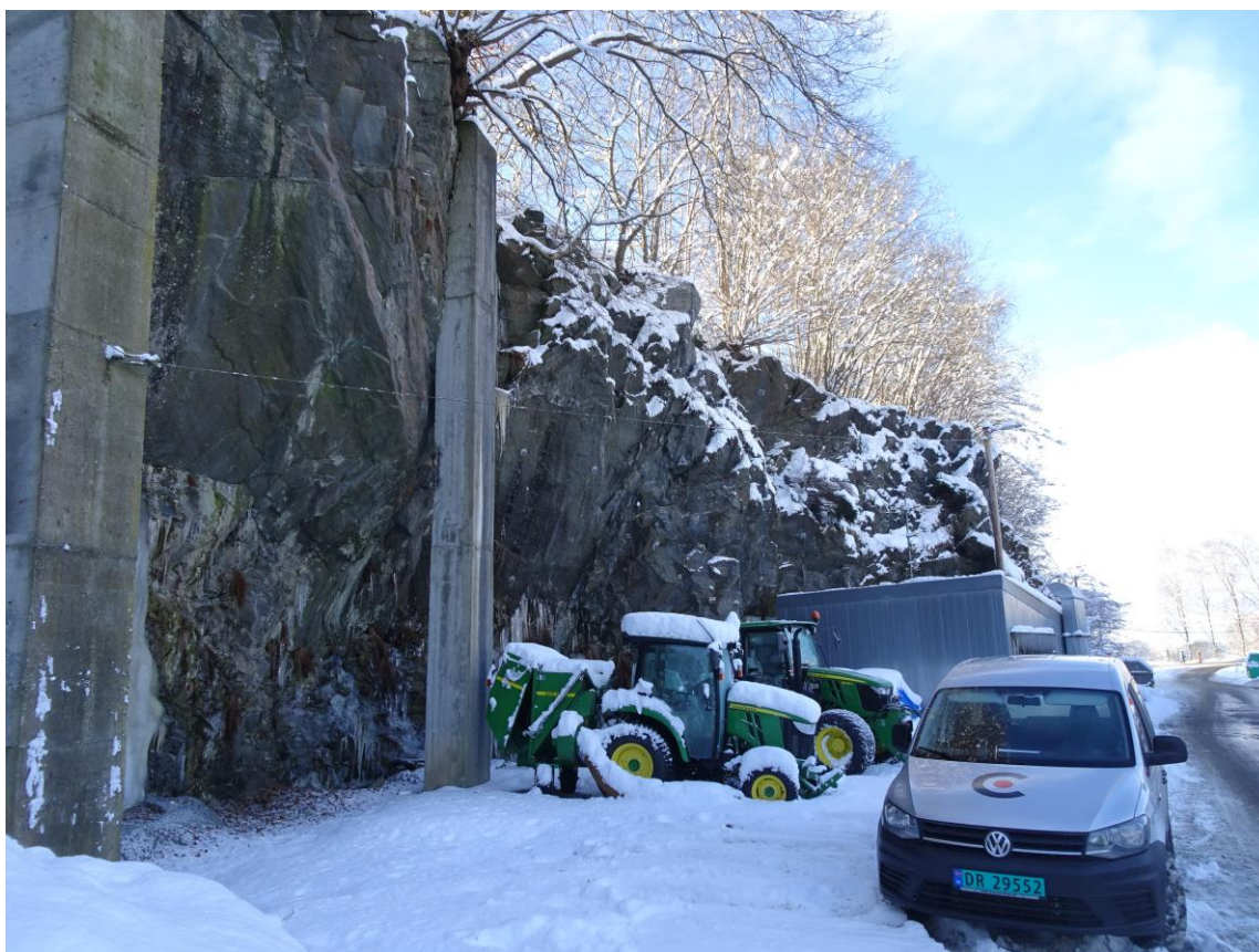
Figur 3. Midtre og vestlig del av nordvendt bergskjæring. Betongsøyler og boltesikring er også med. Bilde tatt mot vest.
