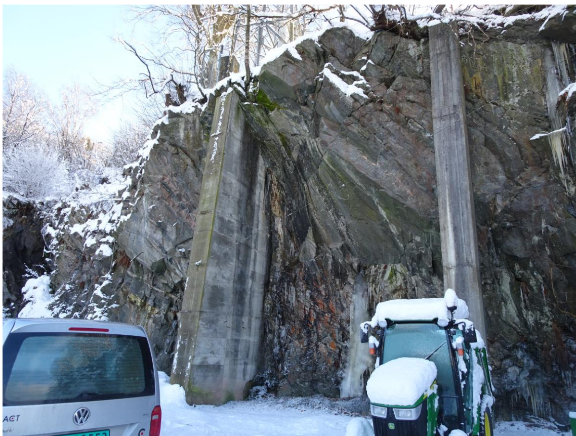
Figur 2. Midtre del av nordvendt bergskjæring, samt betongsøyler som trolig har som hensikt å støtte opp overhengende berg i skjæringen. Bilde tatt mot sørøst.
