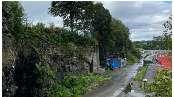
Figur.30 Fjellskråning i plangrensen mot nord.
