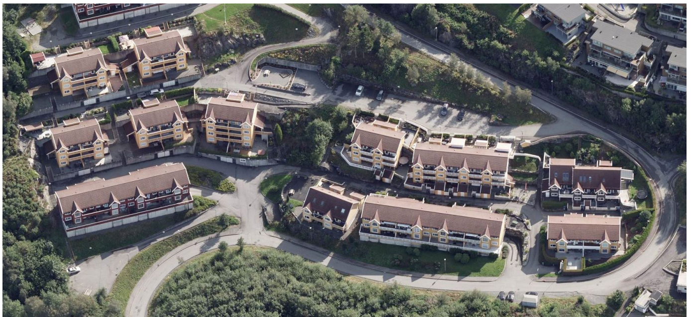
Figur.25 Leilighetsbygg/ rekkehus Råvarden. Kilde: 1881
