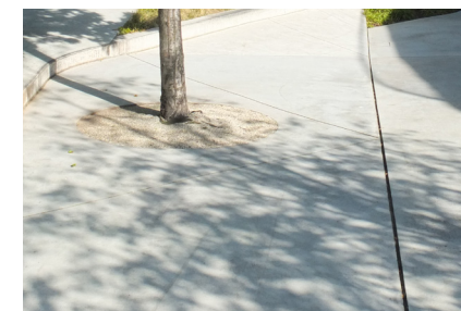
Eksempel på dekke av plasstøpt betong
