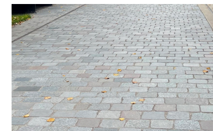
Eksempel på kjøresterkt dekke av naturstein
