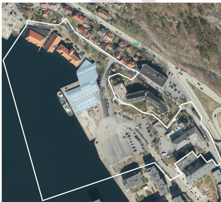
Figur 15. Flyfoto viser hvilken eksisterende bebyggelse som ligger i planområdet. Lyseblå markering viser revet bygg tilknyttet Saltimport som nå er revet.
