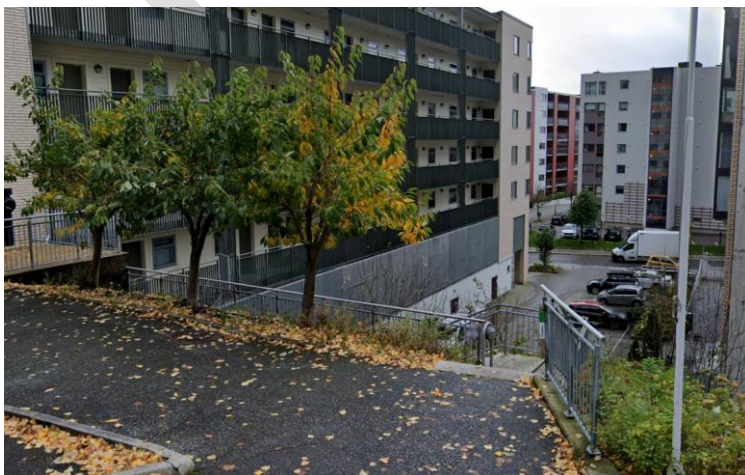
Figur 38. Trappeforbindelse mellom Sandviksveien og Måseskjærveien.
