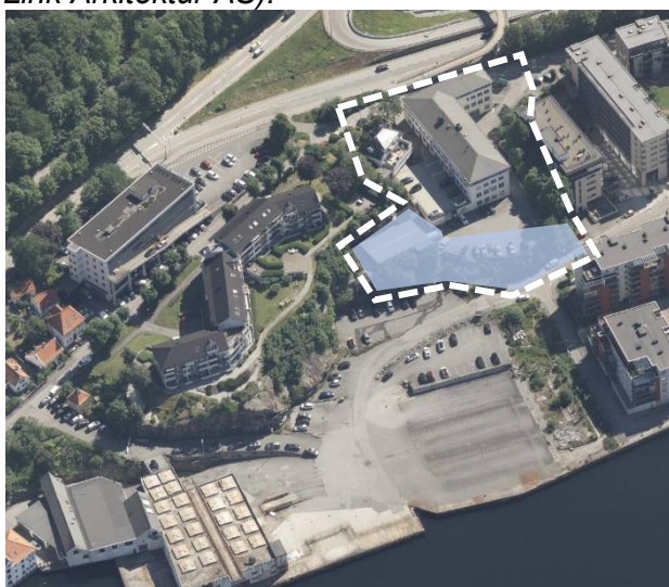
Figur 17. Bebyggelse innenfor hvit markering ligger også innenfor planområdet. Dette er næringsbebyggelse med kontorer, service og verksted i 3-4 etasjer. Eneboligen kalt Ditlefsengen ligger i nær tilknytning til oppført næringsbygg. Eneboligen er nærmere omtalt i vedlagt kulturminnedokumentasjon. Blå markering viser areal som skal rives/transformeres.
