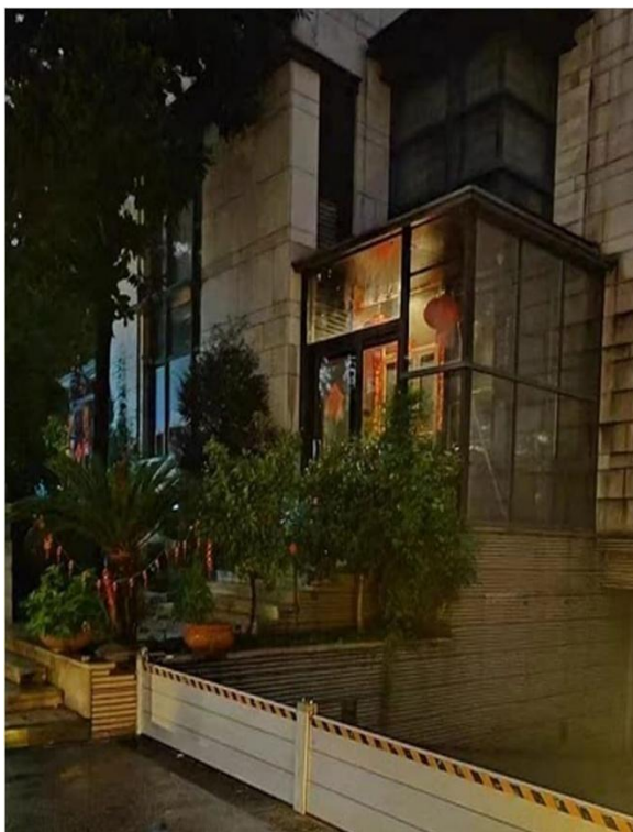
Figur 78. Eksempel på stormflobarriere mot innkjøring til garasjekjeller.
