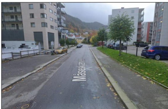
Figur 64. Måseskjærveien har i dag plass til toveis trafikk og tilbud til gående på begge sider av veien. Det er tillatt med kantparkering ved butikken, ellers er det skiltet parkering forbudt. Foto: Google.
