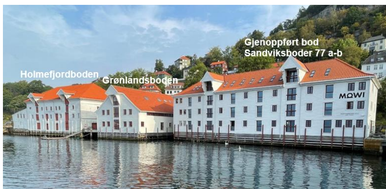
Figur 16. Sandviksboder ligger nord i planområdet. Dette er eldre, restaurerte sjøboder. Bygget til høyre er en nybygd kopi av en eldre sjøbod. To av byggene huser i dag kontorer. (Link Arkitektur AS).
