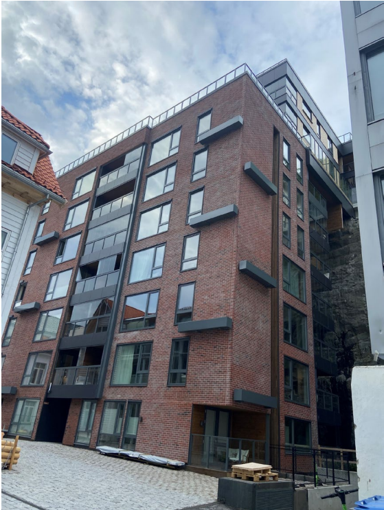
Kalfarveien - avstand mellom bygg 8m
