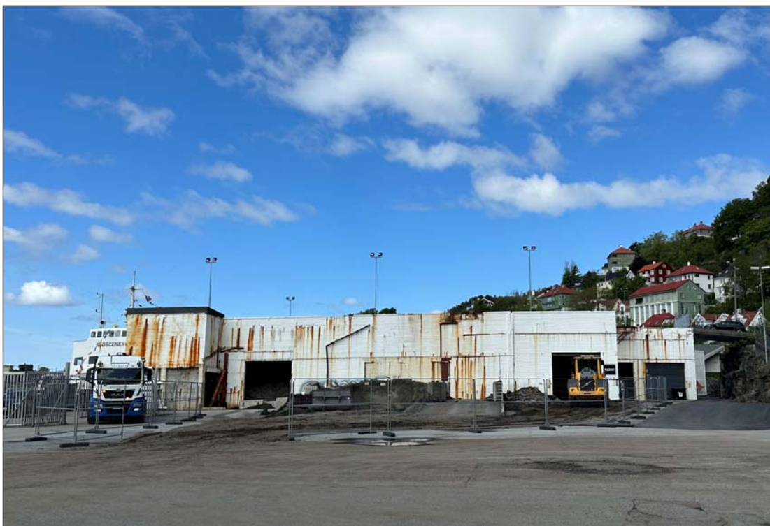
Figur 4.8: Bilde av bygningsmassen som ble tidligere ble benyttet av Saltimport AS. Bygningen og deler av området utenfor leies nå av ENVIR som blant annet benytter det til mellomlager for jordmasser. Foto er tatt mot nord.
