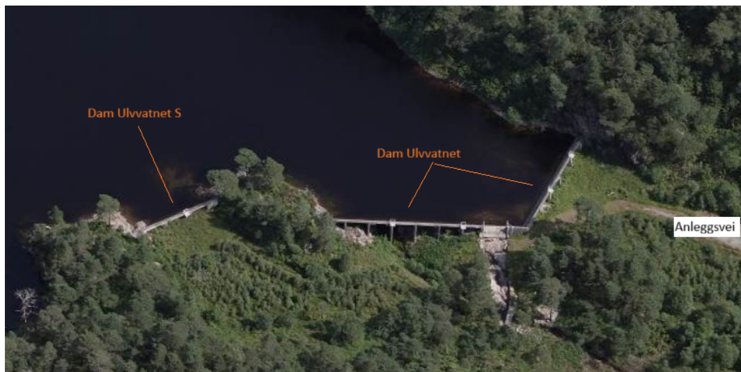
Figur 2: Skråfoto fra 2019 – Dam Ulvvatnet og Dam Ulvvatnet S sett fra vest, med anleggsvei i sør.
