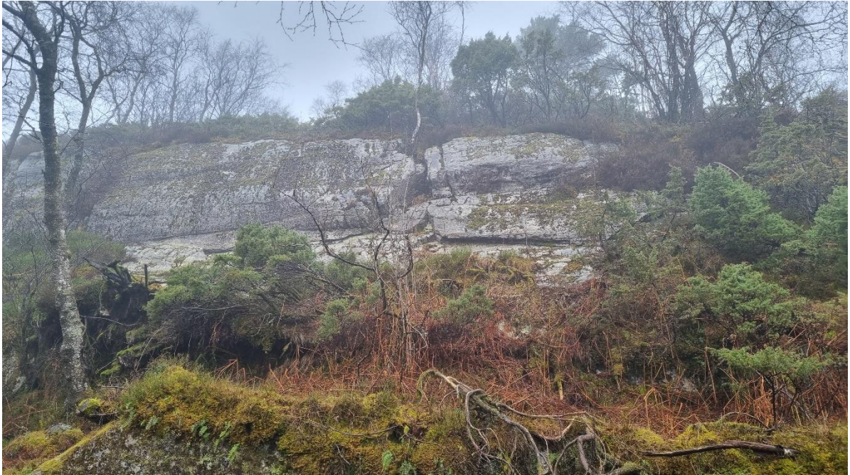
Figur 4: Deler av bergskråning hvor det er aktuelt med rensk og spredte kamstålbolter. Bildet er tatt mot nordvest i sørlige deler av området, i overgangen mellom område regulert til friområde og boligbebyggelse.
