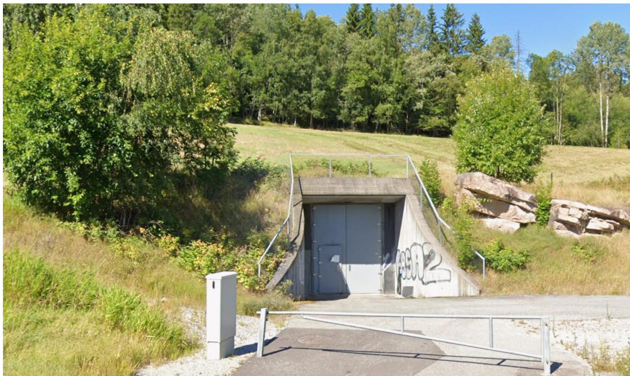
Figur 7-17: Bildet viser eksempel på en rømningstunnel for jernbanetunnel, i Lieråsen Heggedal. Bildet er tatt med for å vise omtrentlig størrelse på portalen.
