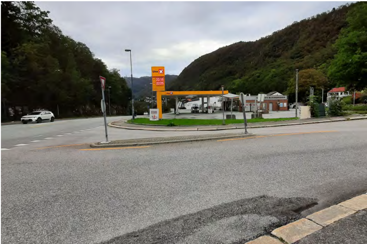
Figur 17: Vegkryss i Nattlandsveien som mangler overgangsfelt.
